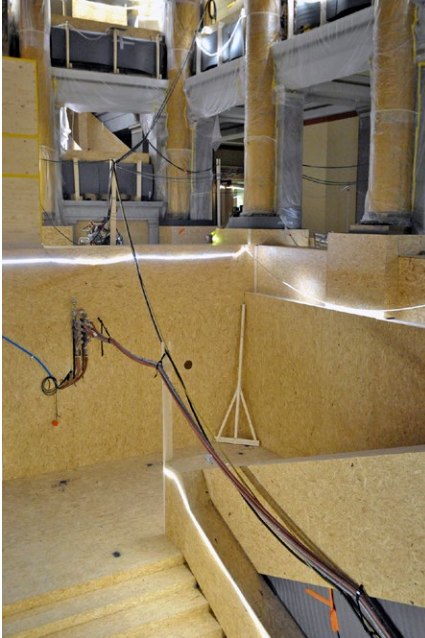
Säätytalon portaikko ja pylväät on suojattu mahdollisimman hyvin.
