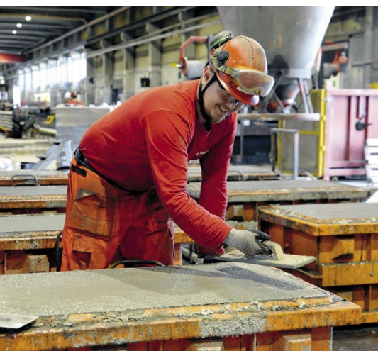
Betonimies Joonas Kujala valaa betonipossuja.
