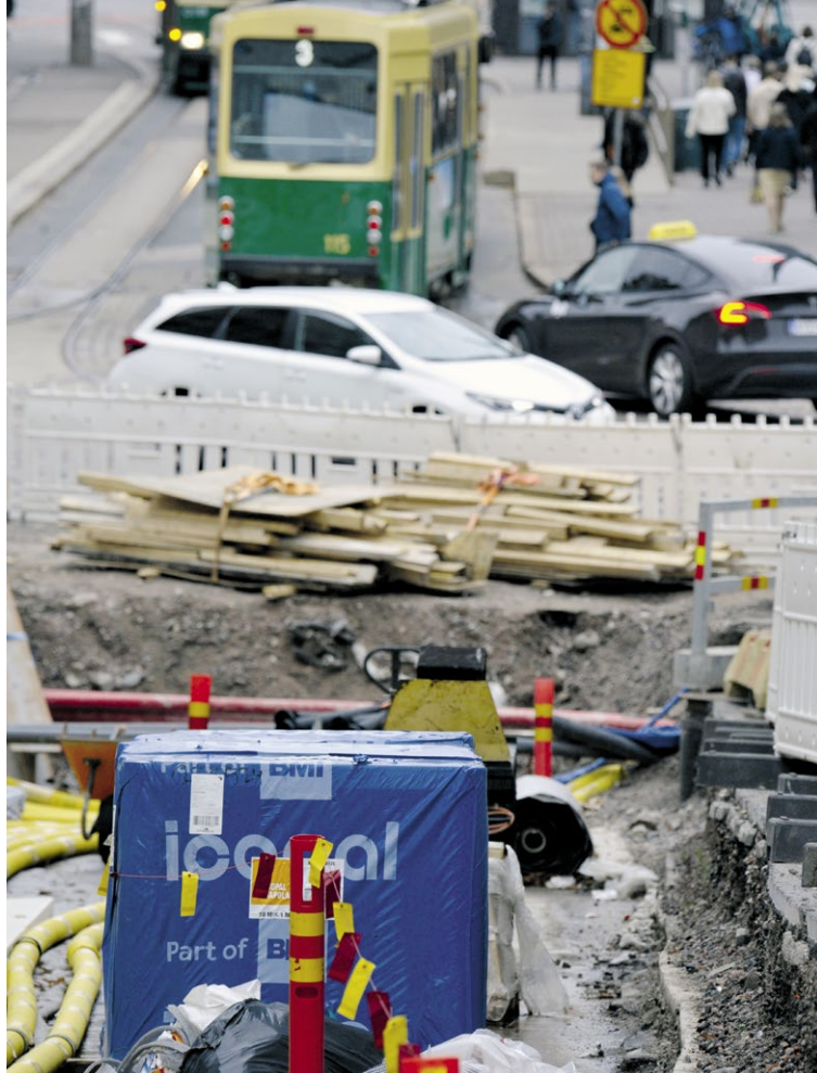
Rakennusyritysten konkurssit näkyvät Helsingissä jo katukuvassa. Maanrakennusyritys E. M. Pekkinen Oy:n konkurssi pysäytti Hakaniemessä katutyöt ja metroaseman kannalta kriittiset vesieristystyöt jäivät kesken. Pekkinen palveluksessa oli satakunta työntekijää.
