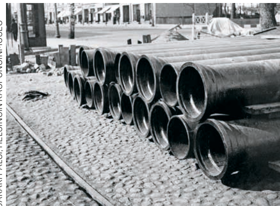
Julkisen rakentamisen suhdannepoliittista merkitystä ei vielä ymmärretty 1930-luvun laman hoidossa. Helsingin Töölöön kuitenkin rakennettiin uusi messuhalli ja parannettiin kunnallistekniikkaa. Viemäriputket odottavat työmaalla vuonna 1934.
