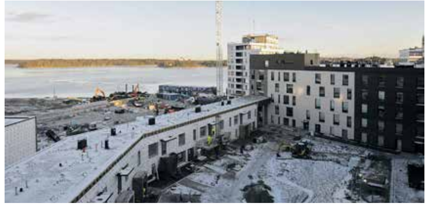
Wandan työmaalla viimeistellään nyt lamellitaloa ja vasemmalla näkyviä kaupunkipientaloja. Pientalojen katoille tulee viherkatot.
