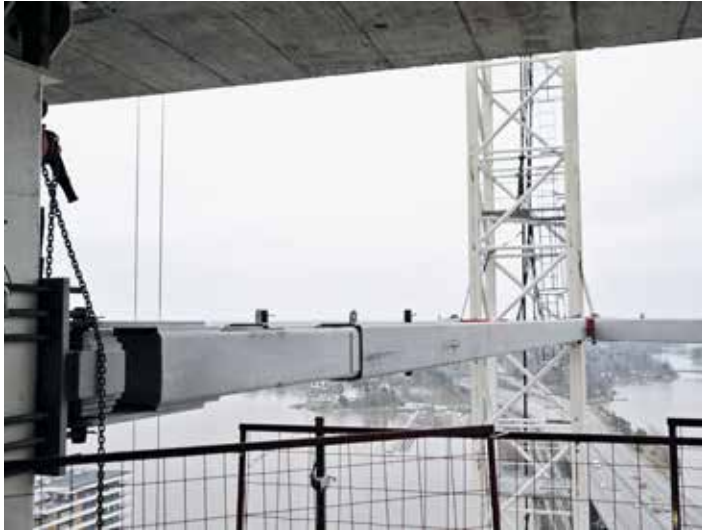
Pihanosturi on tuettu 21. kerroksen kohdalla haruksilla talorunkoon. Haruksen päälle tulee kulkusilta nosturiin.
