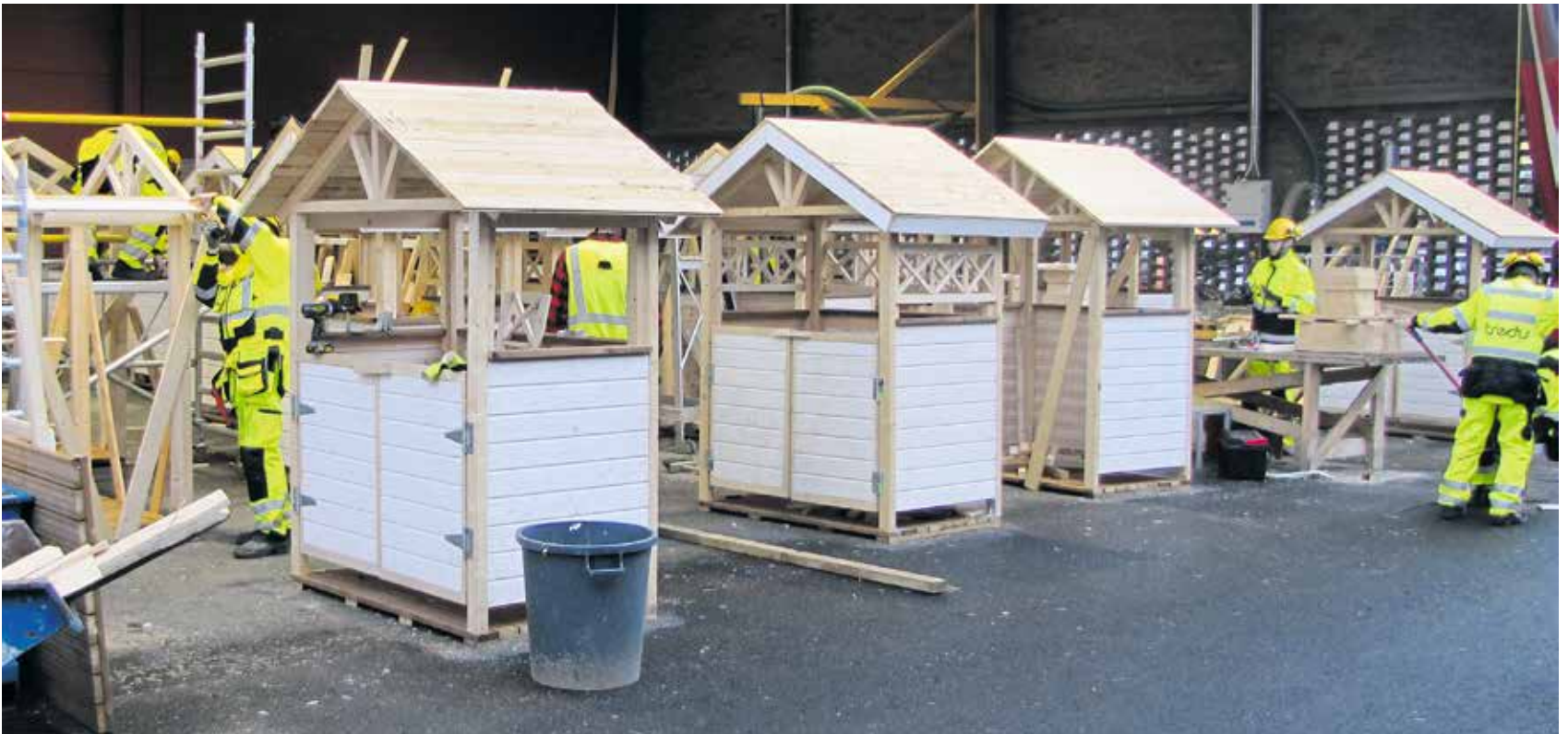
Tredun Kangasalan kampuksella päästään rakentamaan ulkona katoksen alla. Tässä valmistuu jäteastioiden suoja, jotka tehdään tilaistyönä.
