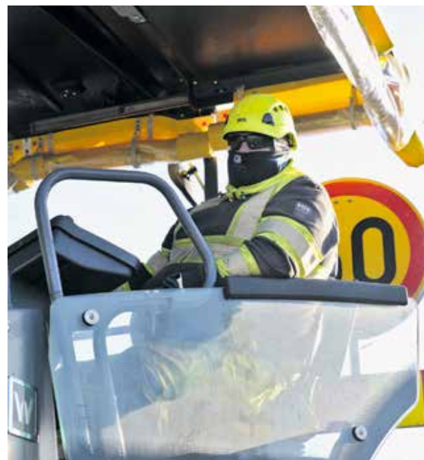
Vaikka asfaltti on kuumaa, Mikko Juutin työpisteellä pitää pukeutua lämpimästi.
