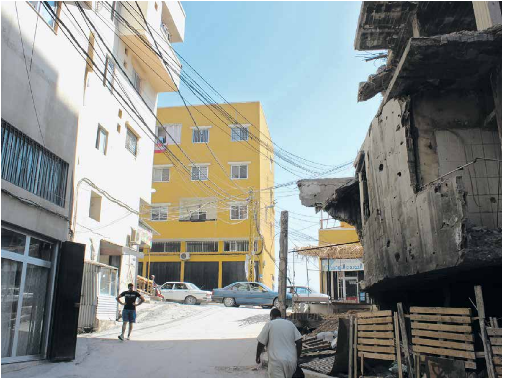
Nahr El Baredin vanhan ja uuden puolen erottaa toisistaan tie. Uudella puolella näkee vielä vuoden 2007 sodassa raunioituneita rakennuksia.
