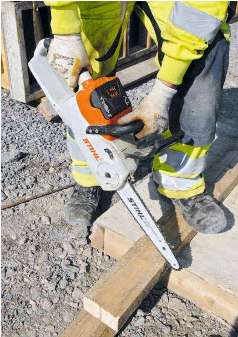
Rakennusmiehenä Skanskan kerrostalotyömaalla työskentelevä Valtteri on tyytyväinen akkukäyttöisiin moottorisahoihin muuttien teossa. Erityistä kiitosta hän antaa pakokaasujen puuttumisella ja akkujen pitkälle kestolla.
