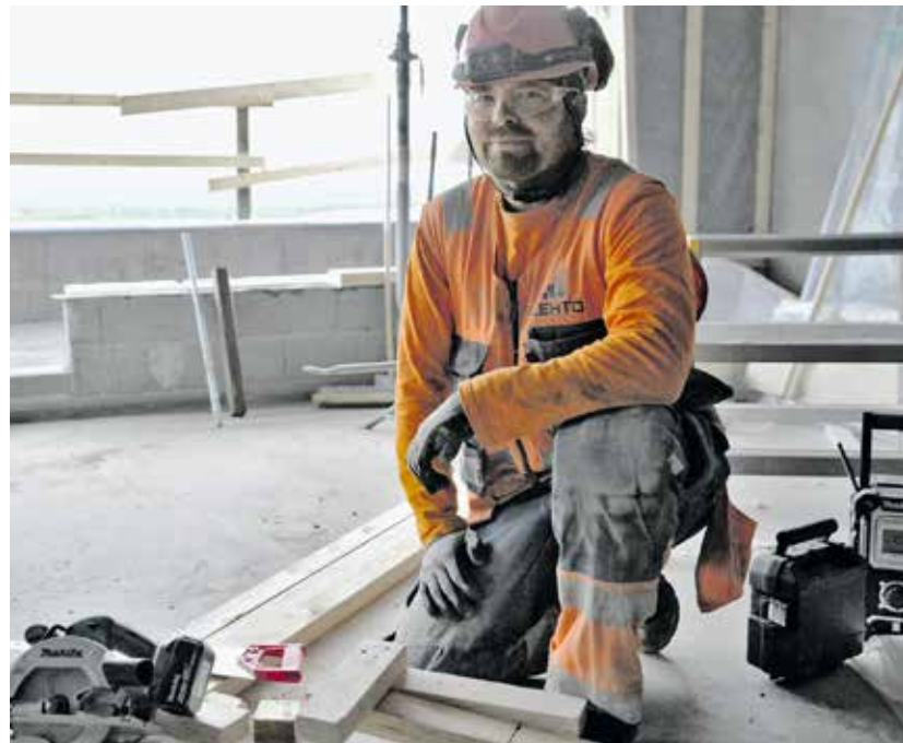
Harri Anttila pärjää työmaalla paremmin pakkasessa kuin kesähelteellä.
