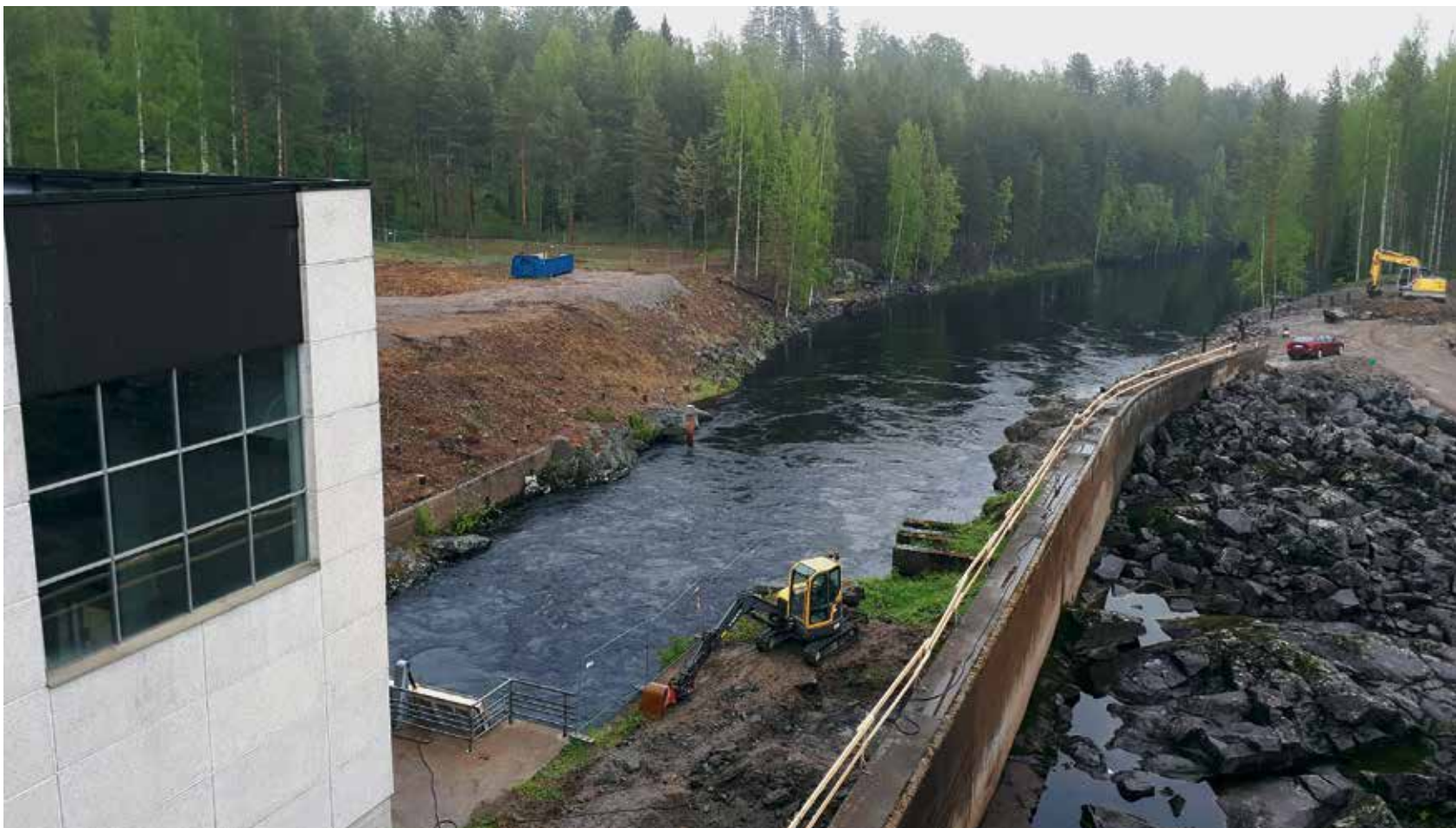
Kalatien työmaalla aloitettiin holvin tekeminen heinäkuussa. Kun kalatie otetaan käyttöön ensi vuonna, Vattenfall seuraa kalojen viihtymistä ja voi parantaa olosuhteita muun muassa veden määrää ja virtausnopeutta muuttamalla. Betonipohjalle on mahdollista tuoda kiviä muistuttamaan luonnosta.
