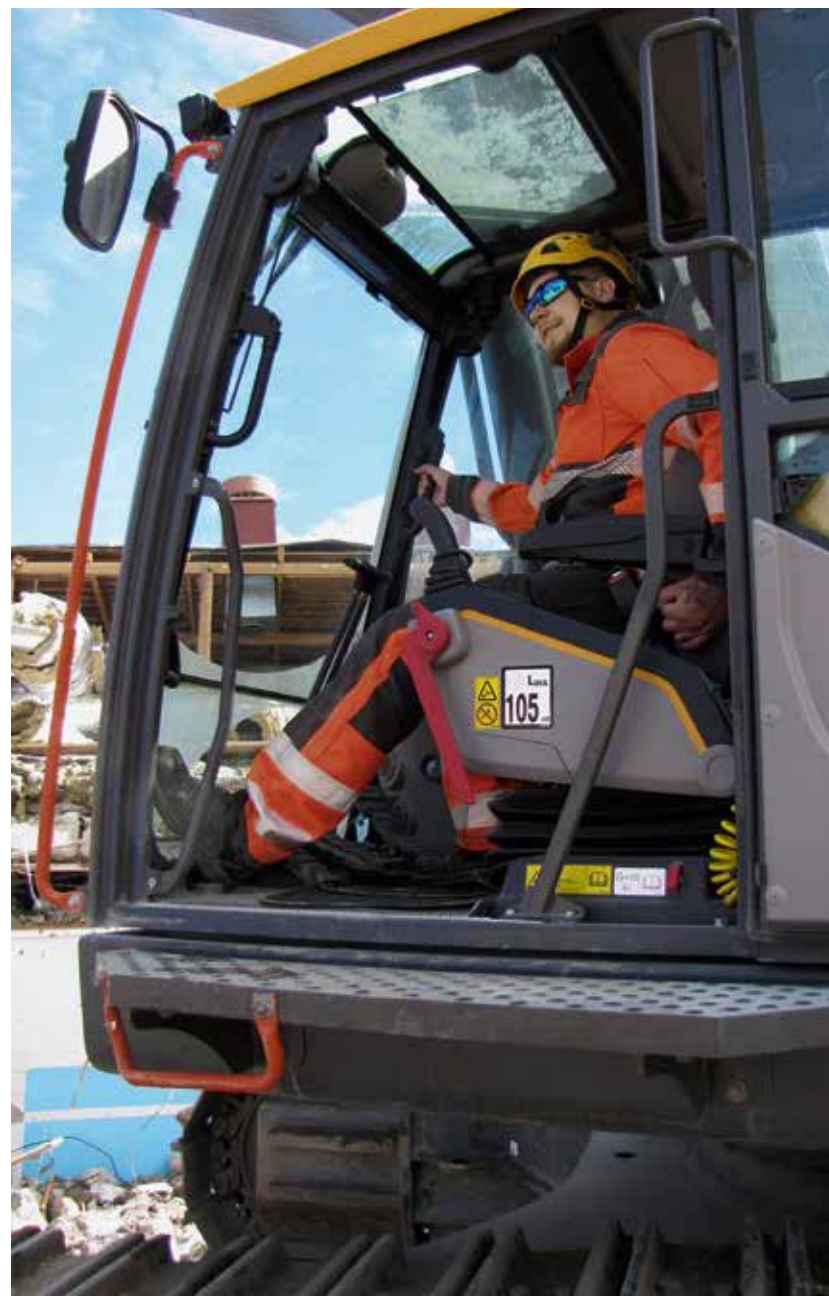
Sami Räisäsellä riittää purettavaa. Usein rakennuksen purkamisen syynä ovat sisäilmaongelmat.
