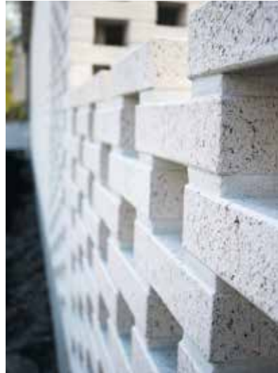
Pitsimuurauksen taidonnäyte.
