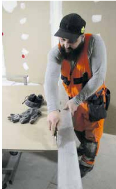
Kirvesmies Mika Niinisalo asensi kipsilevyjä pannuhuoneen alakerran väli-seiniin.
