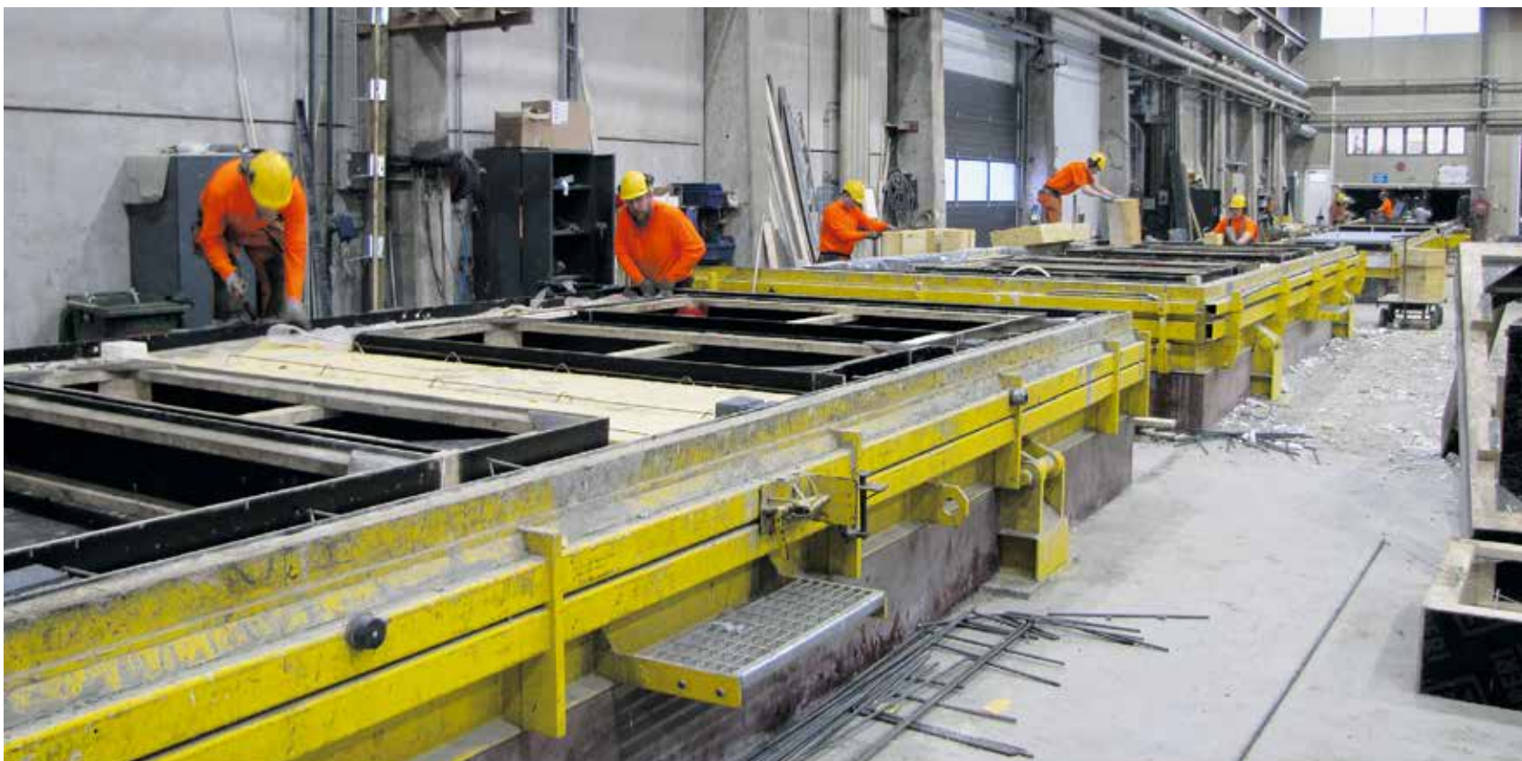
Jämsän elementtitehtaalla on riittänyt töitä niin, ettei kaikkia tilauksia ole edes pystytty ottamaan vastaan. Ensi vuosikin näyttää hyvältä.
