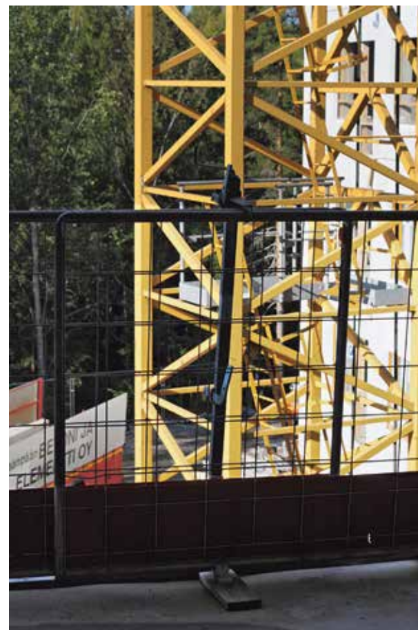
Putoamissuojauksen voi tehdä huonosti taikka hyvin. Metalliaita voittaa lankunpätkät turvallisuudessa ja kätevyudessa.
