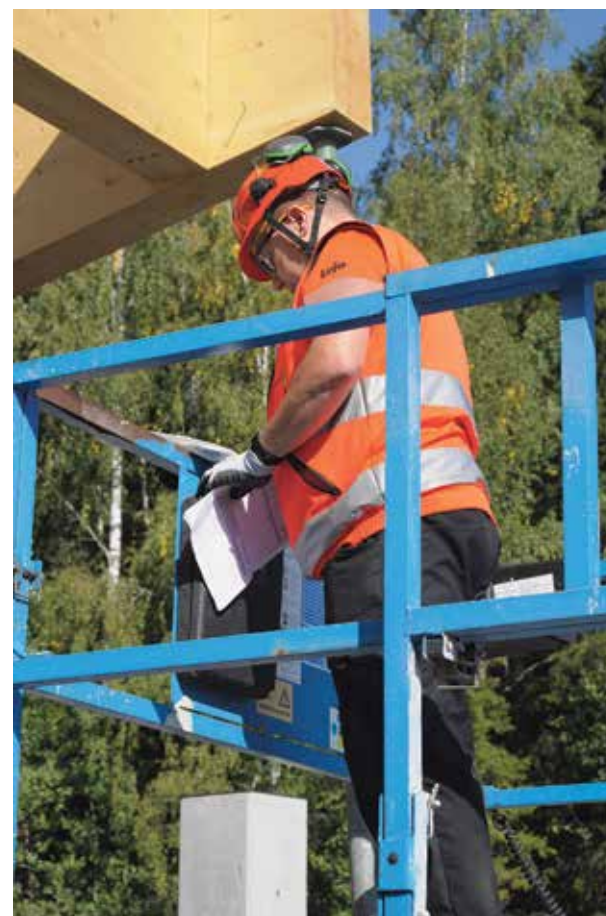
Koneiden paperit ovat useimmiten kunnossa suomalaisilla työmailla.
