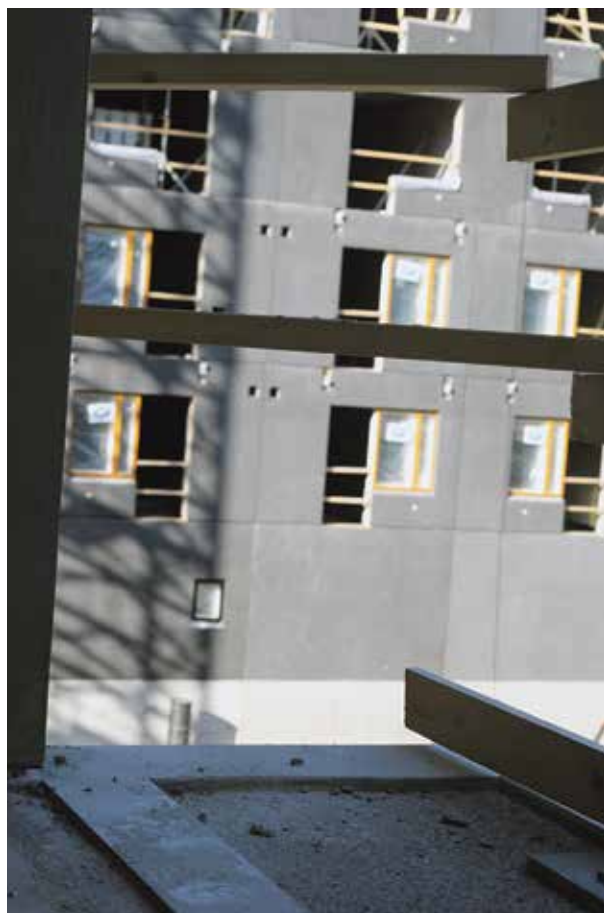
Putoamissuojauksen voi tehdä huonosti taikka hyvin. Metalliaita voittaa lankunpätkät turvallisuudessa ja kätevyudessa.
