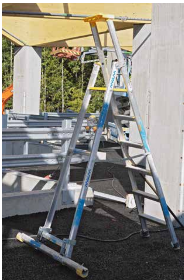
A-tikkaiden tukirauta poistetaan usein kätevyden takia. Sillä on kuitenkin oma tarkoituksensa. Tässä kuvassa VRP:n työmaalla tikkaat ovat asianmukaiset.
