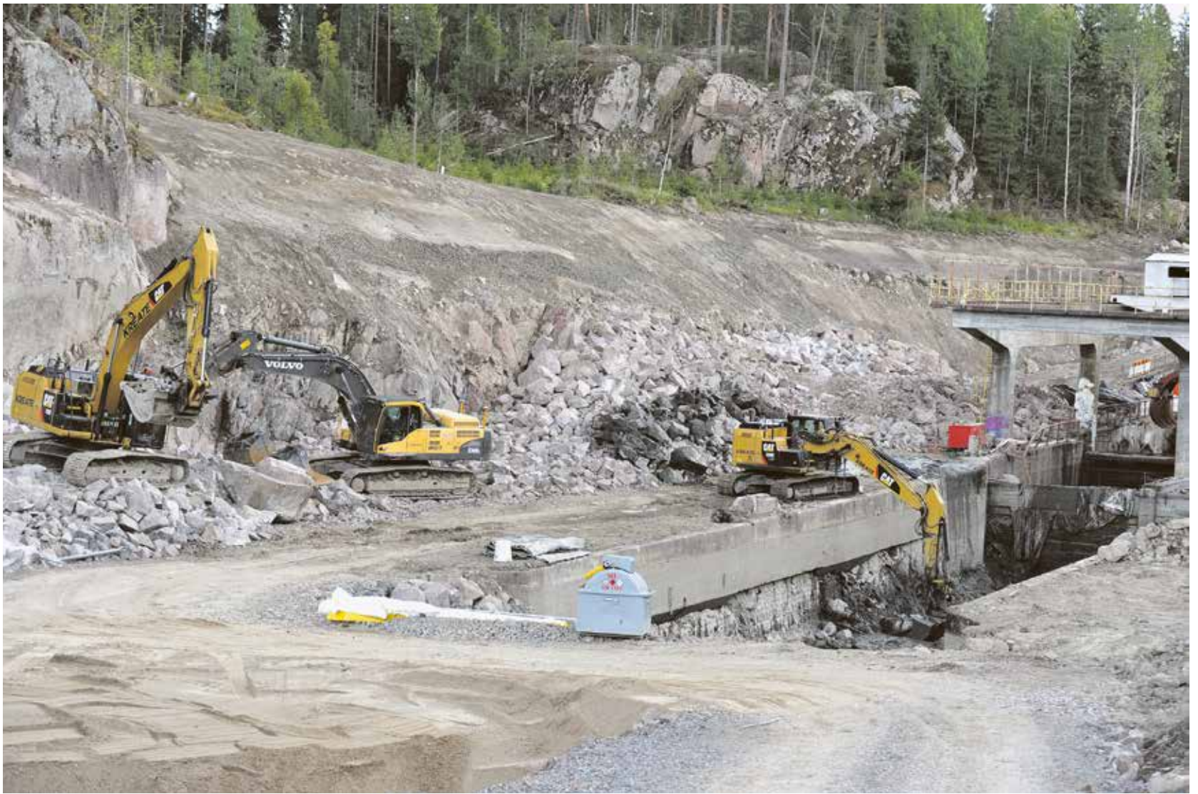
Kimolan kanavan sulkualueella tehdään pengerrystöitä.
