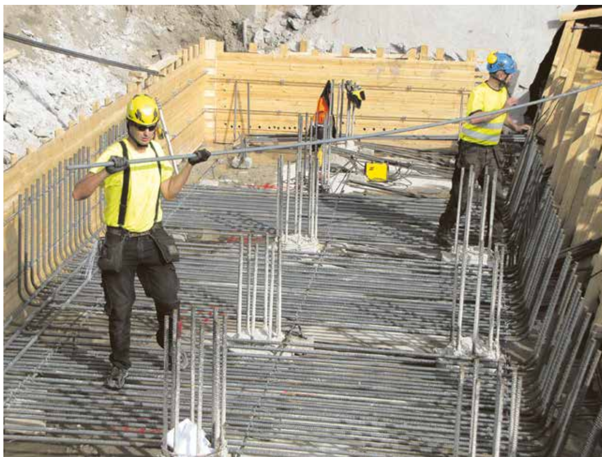
Raudoittajat Perttu Paso (vas.) ja Petri Hämäläinen kiinnittävät harjaterästä anturoihin.
