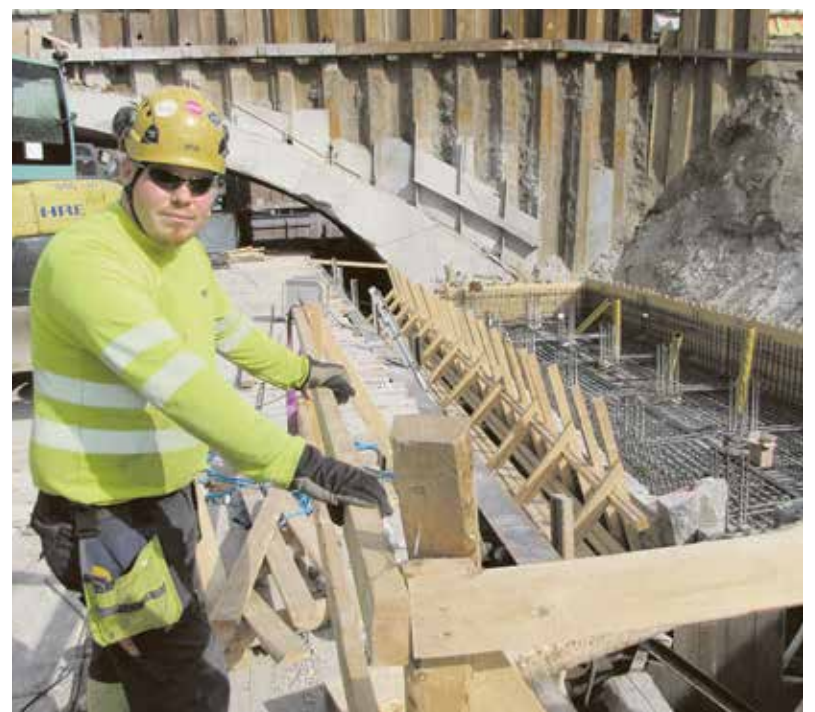
Rakennusmies Janne Lilius on Hämeensillan pääurakoitsijan YIT-infran ainoa vakituinen työntekijä siltatyömaalla.
