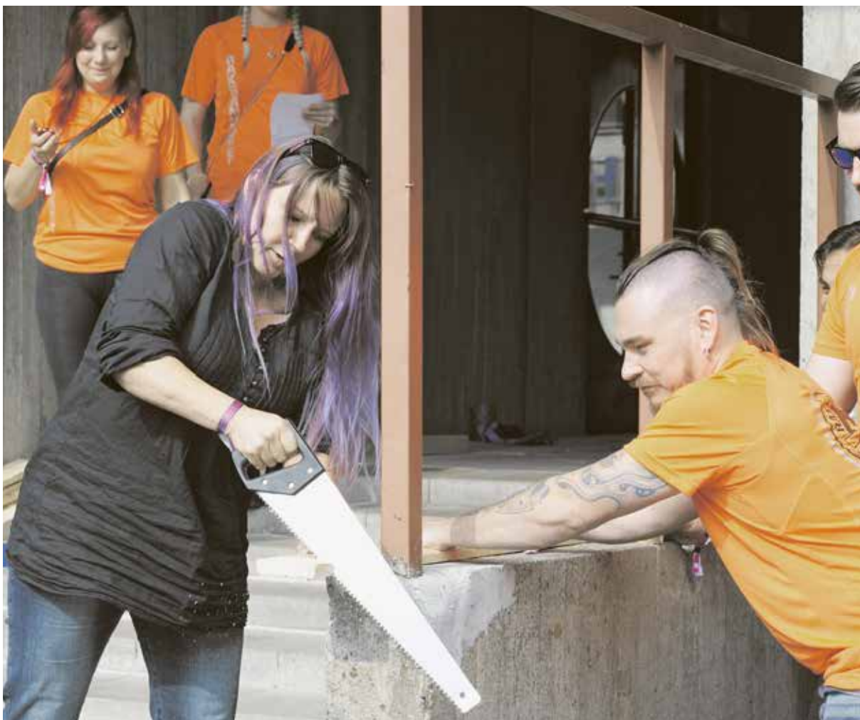
Raksanuorten toimintarastilla sahattiin, naulattiin ja ruuvattiin.
