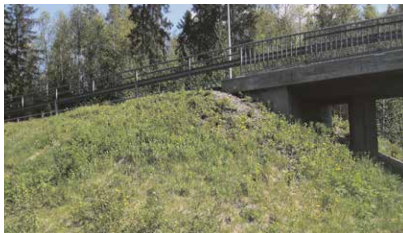
Oulussa on käytetty rengasleikettä kevyenliikenteen väylän kevennysrakenteena. Kuva: Hannu Aurinko
