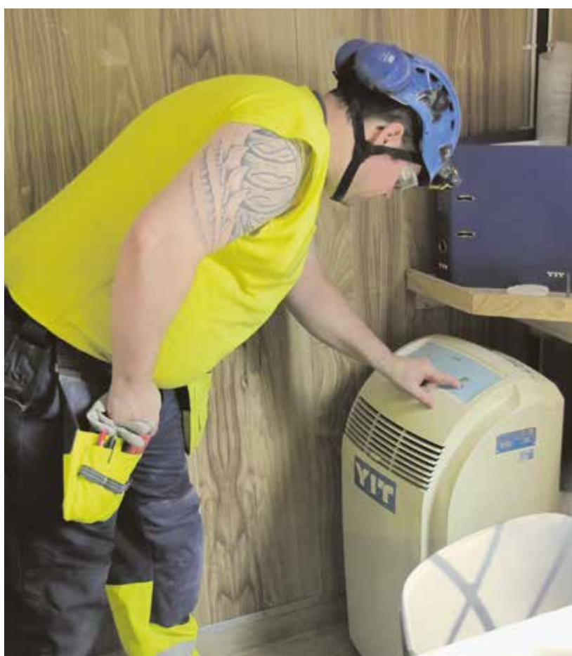
–Tämä näyttäisi olevan asennettu 16 asteeseen, mutta kopissa on silti 28 astetta, manailee työsuojeluvaltuutettu Marko Perälä sosiaalitilojen ilmastointilaitetta.
