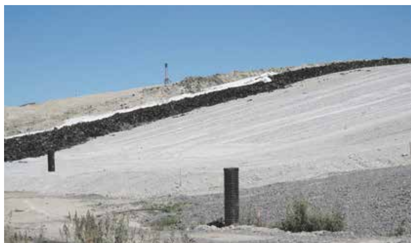
Kaatopaikan pintarakenne, jossa musta kerros on rengasleikettä kuivatusrakenteena. Kuva Nurmon kaatopaikan sulkemusrakenteesta. Kuva: Hannu Aurinko
