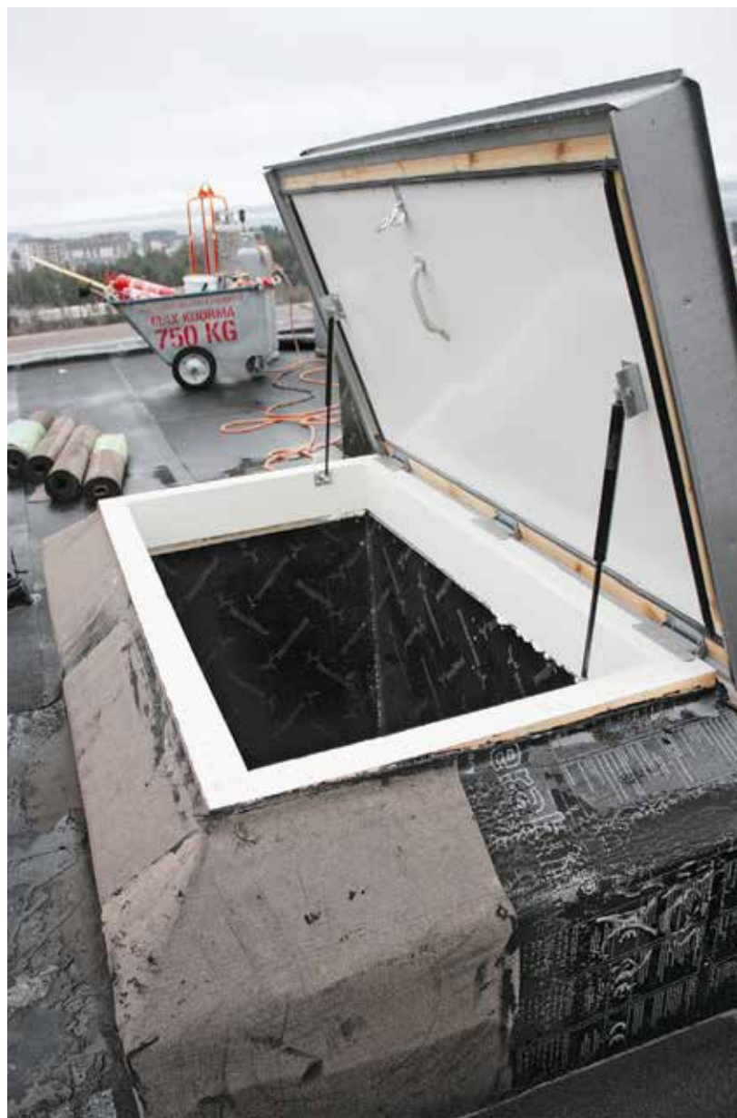
Ovi työmaalle 8. kerrokseen. 3 päivän hommat vielä edessä tässä kohteessa; kattoa yhteensä noin 300 neliötä.
