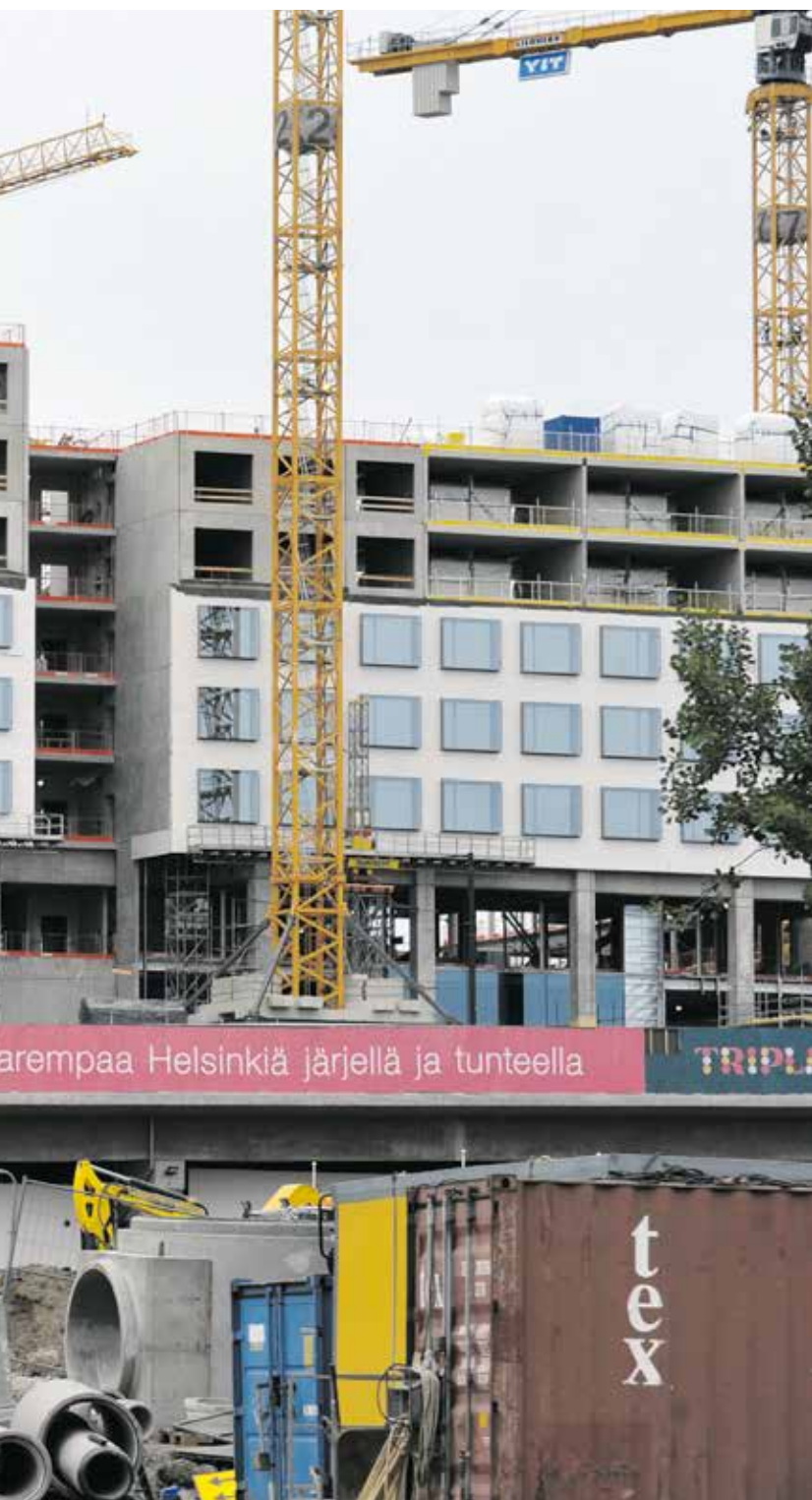
Helsingin Triplan työmaa on YIT-konsernin suurimpia rakennuskohteita.
