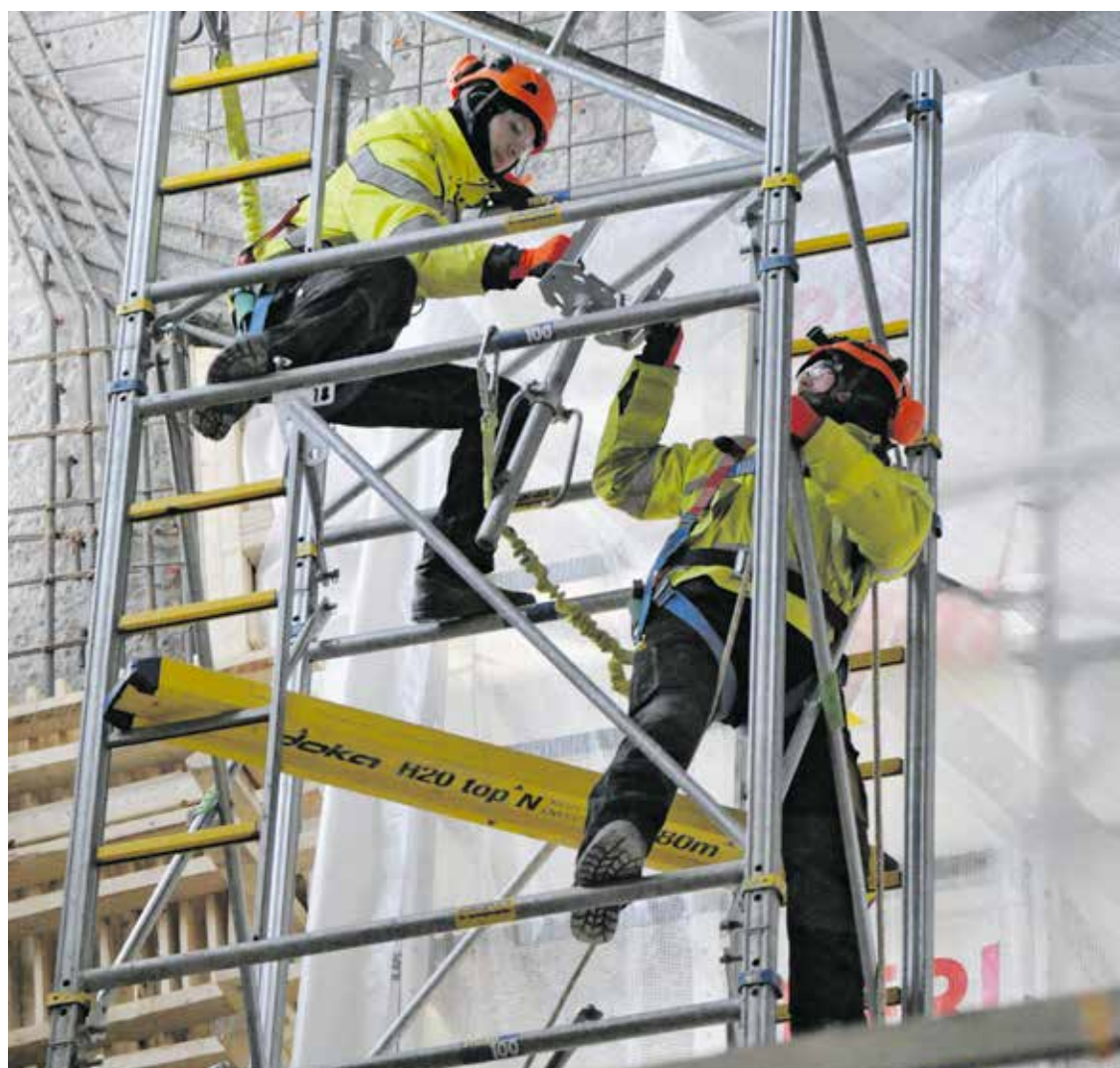
Olympiastadionin työmaalla riittää telineasennusta.
