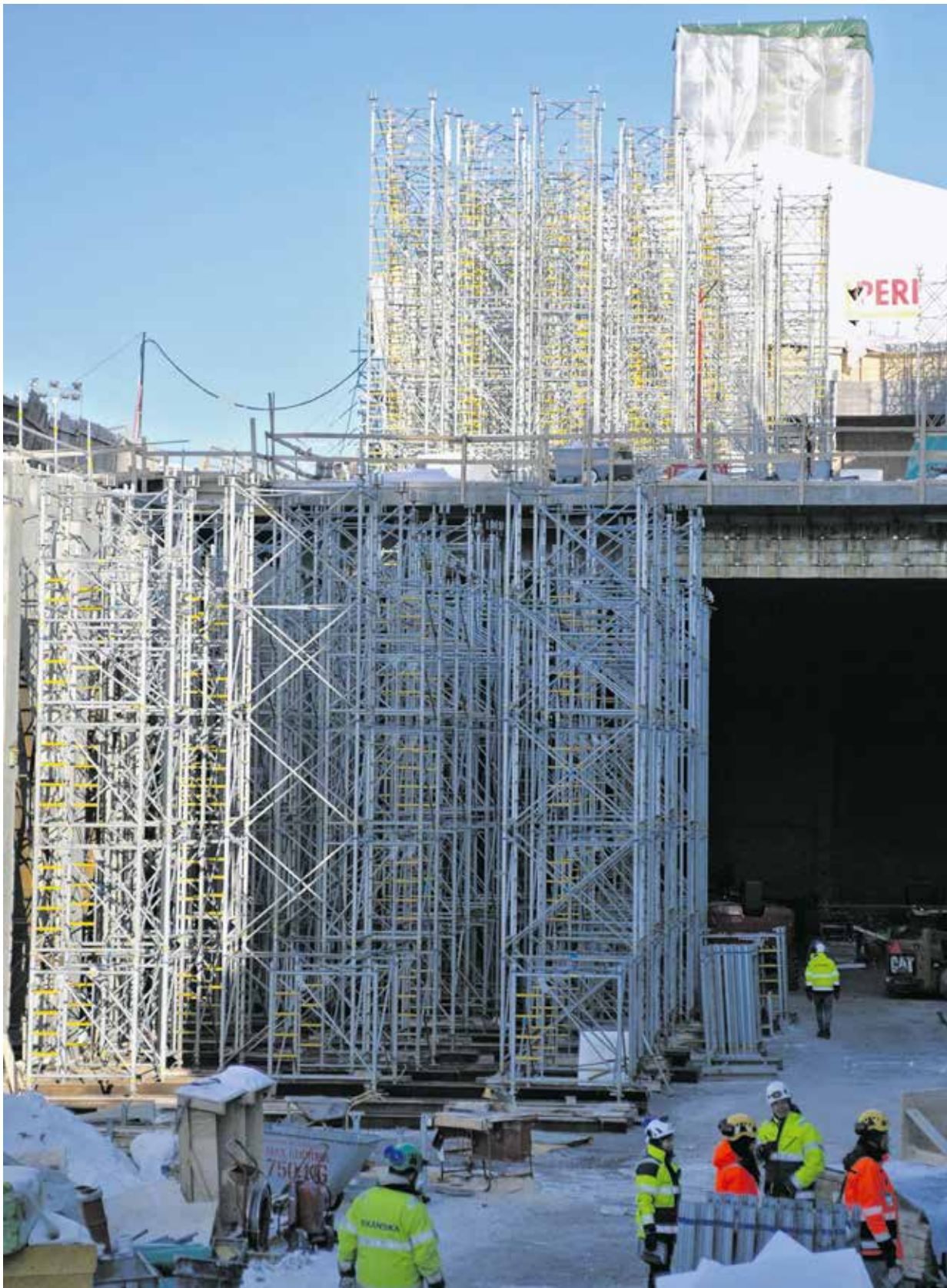
Stadionin alle louhitaan lisätilaa. Vasemmalla valmiita telineblokkeja, joita nostellaan paikoilleen tarpeen mukaan.
