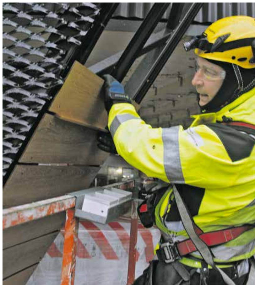
Vili Uusitalo asennustyön jälki kestää lähemmäkin tarkastelun.
