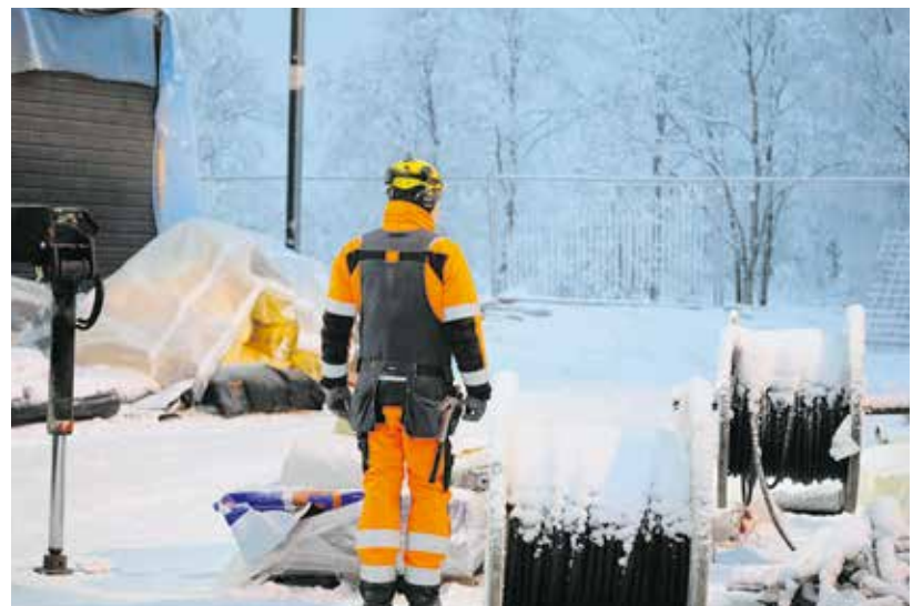
Sinisessä hetkessä erottuvat huomiovärit hyvin Kultahipun työmaalla.
