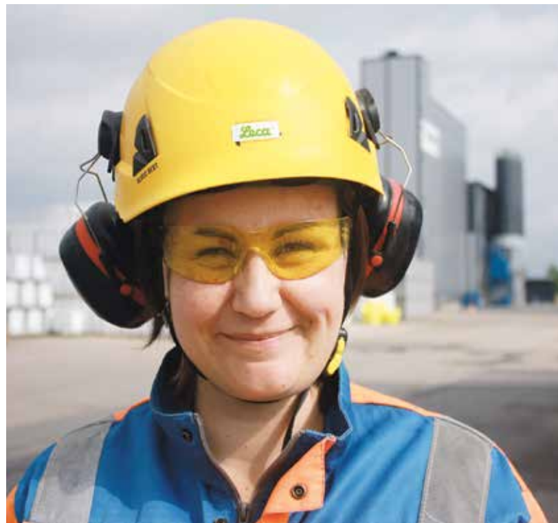
Tehdaspäällikkö Hanna-Leena Heikkilä sanoo, että tehtaan toiminnassa ammattitaitoiset työntekijät ovat tärkeimmällä sijalla. Taustalla Leca Finland -yhtiön Oitin pisteen uudempi tehdaslaitos.
