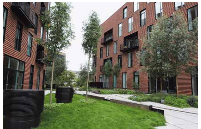
Tiililaatoilla verhoiltu betoni ja runsaat istutukset tekevät tästä Kööpenhaminan keskustan asuinalueesta, Krøyers Pladsista viihtyisän ja kauniin.
