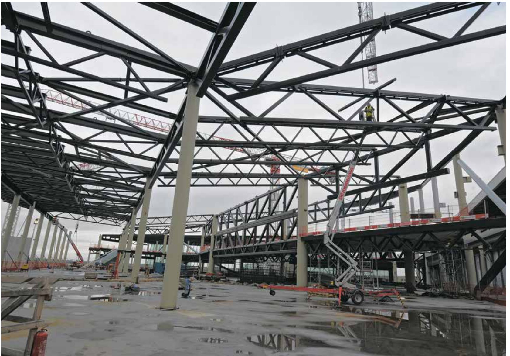
Plazan normaali pilariväli on yli 12 metriä ja teräsristikoille tuli painoa 30 tonnia kappaleelta.
