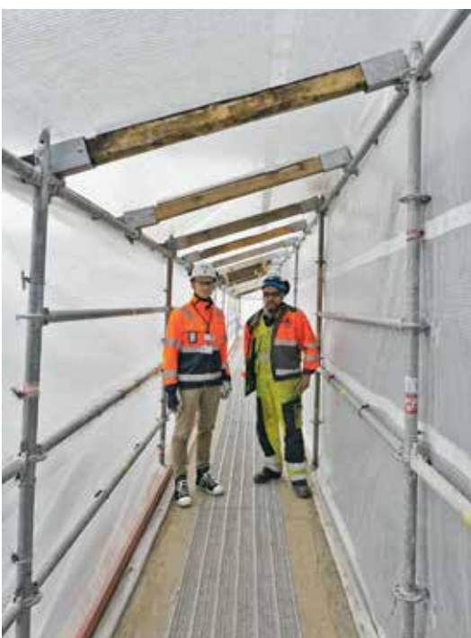
Työpäällikkö Jarkko Lahti ja työsuojeluvaltuutettu Kimmo Myllykangas ravaavat tällaisia putkia pitkin sosiaaliloista työmaalle.
