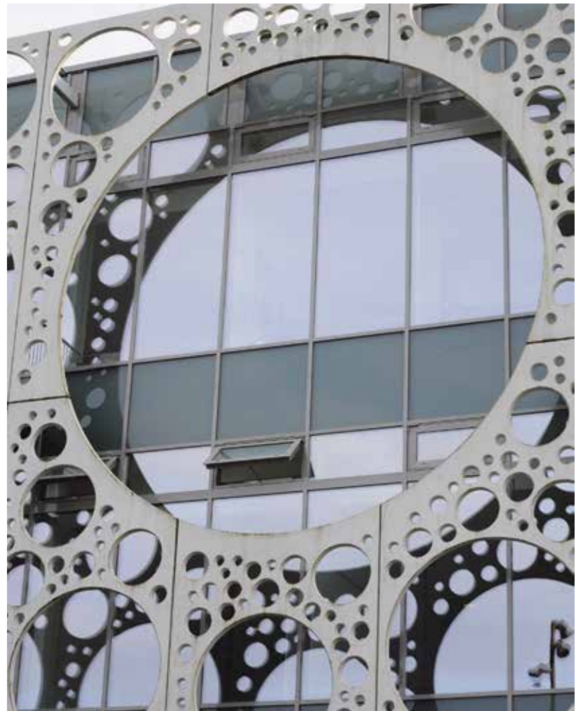
Odensen Teknillisen korkeakoulun julkisivu on lasia ja HiCon-teräs-kuitubetonista tehtyä pitsikuvia.
