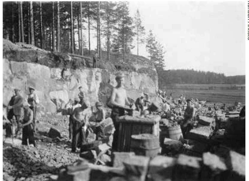
Nupukiventekoa Kuusankosken hätäaputyömaalla vuonna 1931.
