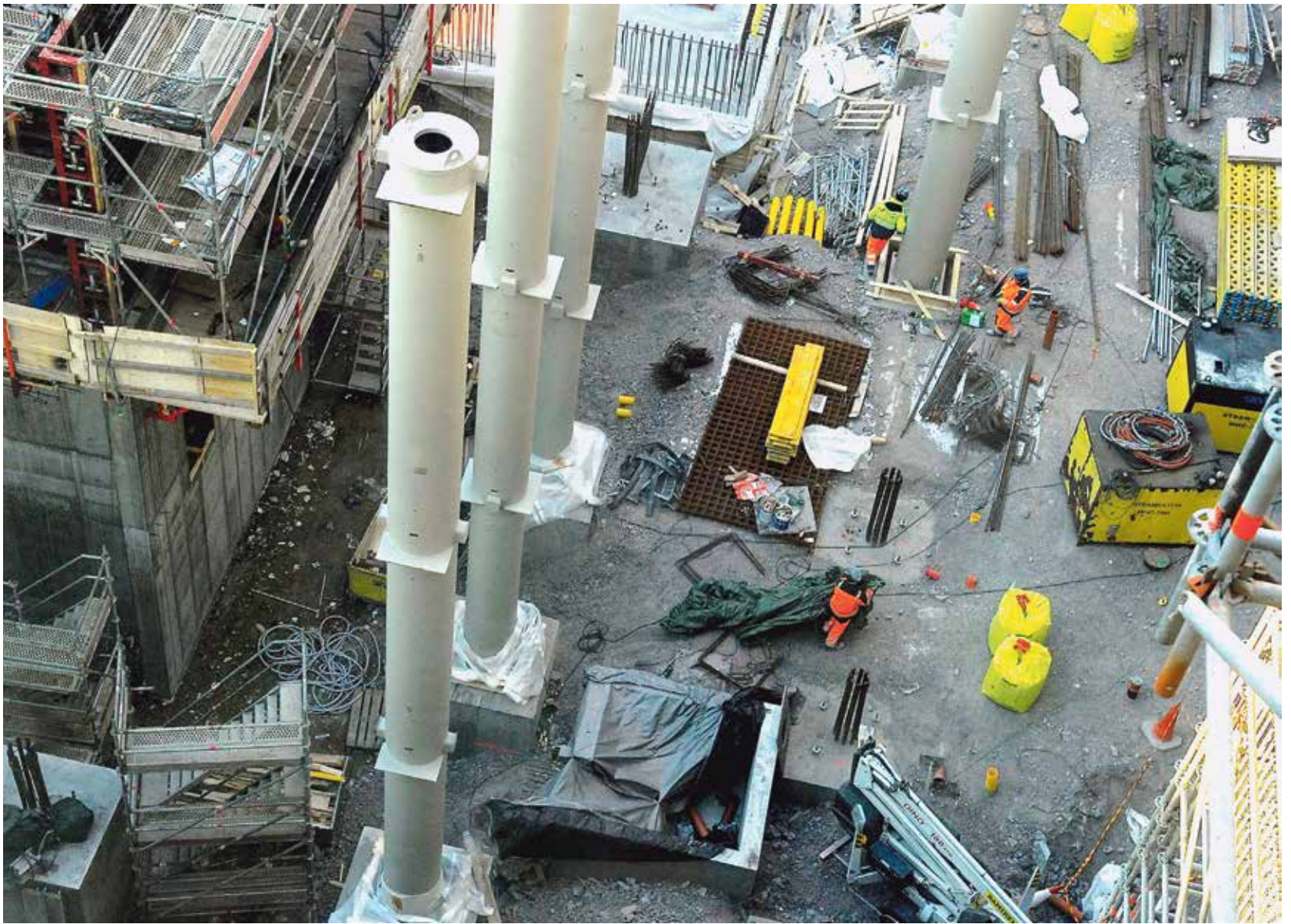
Kalasadaman tornityömaalla ja muilla suurilla rakennuksilla työterveyshoitaja Inna Prela on kiinnittänyt huomiota etenkin meluun ja yhteisen työmaan työturvallisuusriskeihin, kun kaikilla ei ole samaa tietoa vaaroista ja työturvallisuuskäytännöistä.
