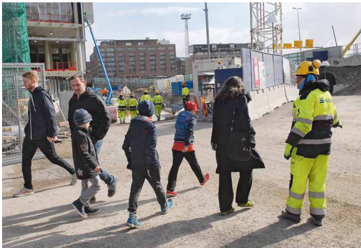
Pienimminkin urakoitsijan tulee ottaa huomioon toiminnassaan, että turvallisuus taataan myös ulkopuolisille. Kalasatamassa rakennetaan keskellä vilkasta liikennettä ja asuinalueita.
