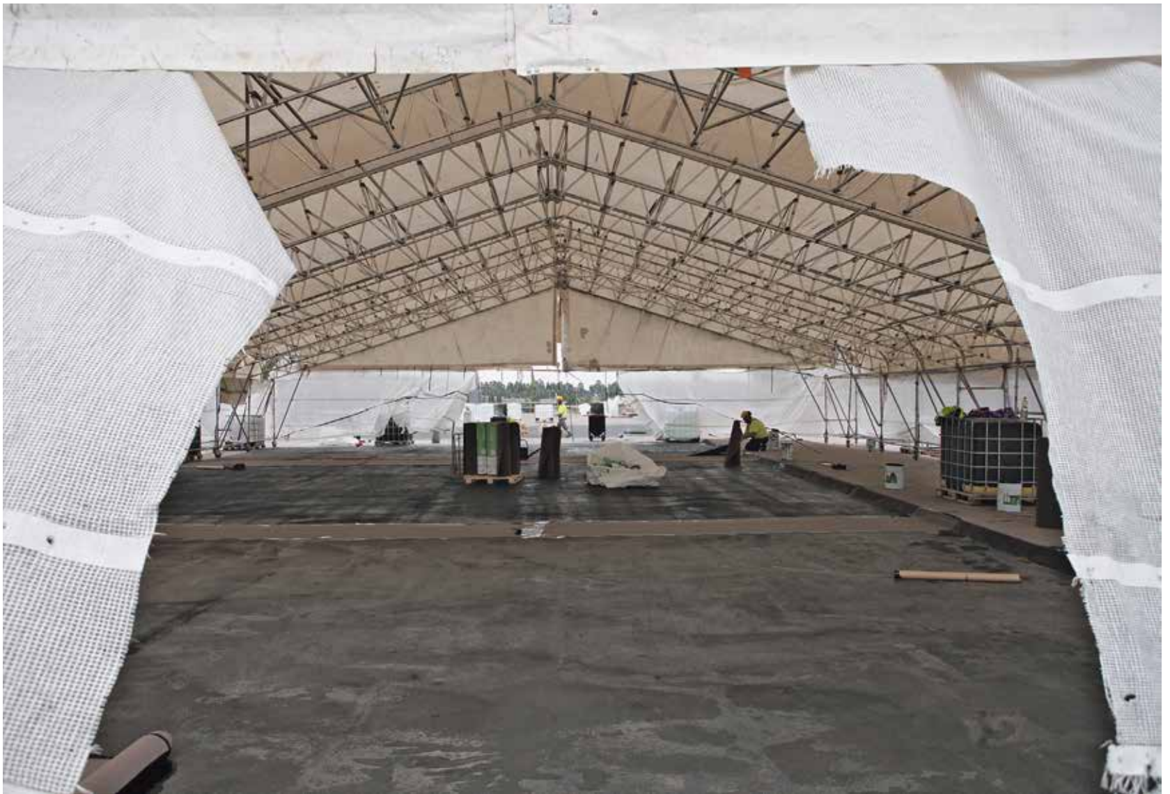
Siltojen vedeneristystyöt tehdään nykyisin sääsuojan sisällä.
