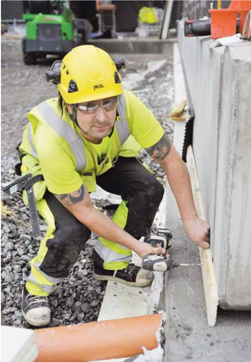
Työsuojeluvaltuutettu Jukka Silvennoinen on siirtynyt siltatyömailta talojen pystytykseen.
