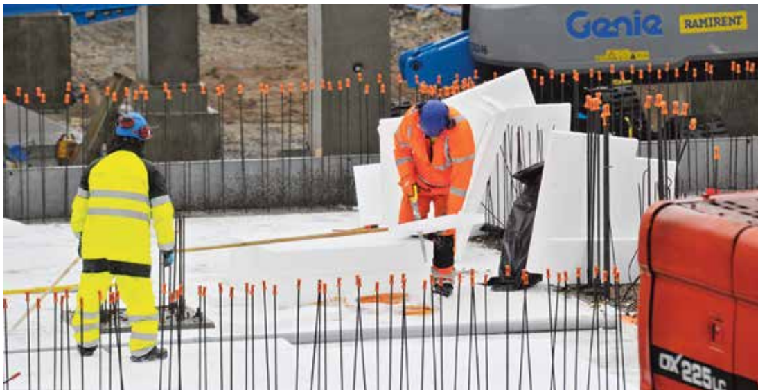
Kainuun keskussairaalan työmaalla riittää töitä vuoteen 2021 asti.
