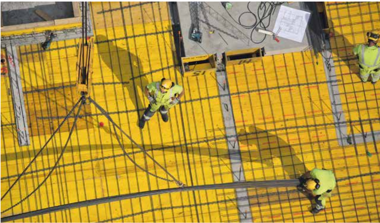
Torninosturinkuljettajalla on tärkeä rooli turvallisen työmaan luomisessa.
