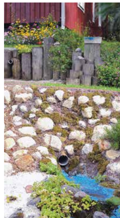
▲ Juuri valmistunut, Niksibetonista tehty reikäistutuspenger.
