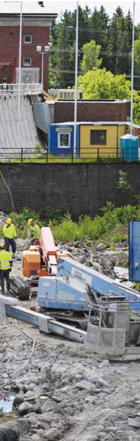
Imatran voimalan työmaa on tällä hetkellä Suomen suurin voimalaitosremontti.
