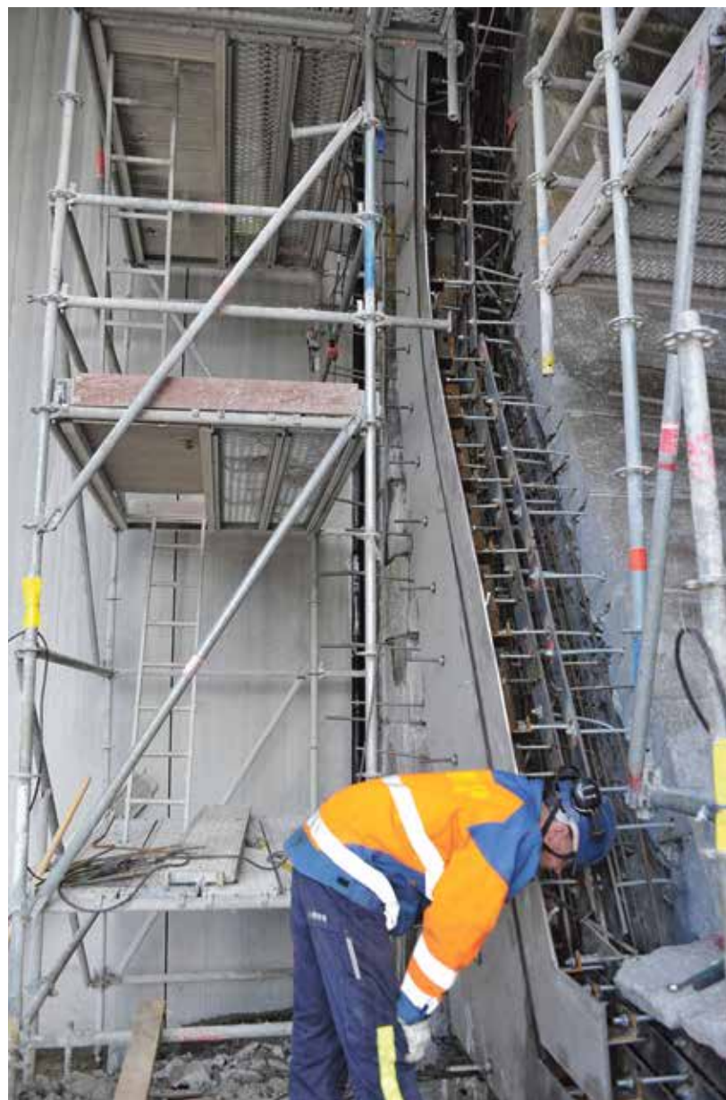
Valumuotteja väännetään myös teräksestä. OMP Groupin Teemu Hallikainen tarkastaa lopputulosta.
