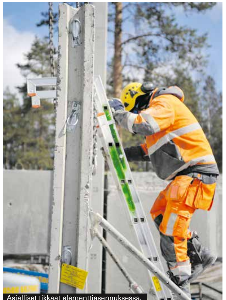
Asialliset tikkaat elementtiasennuksessa.
