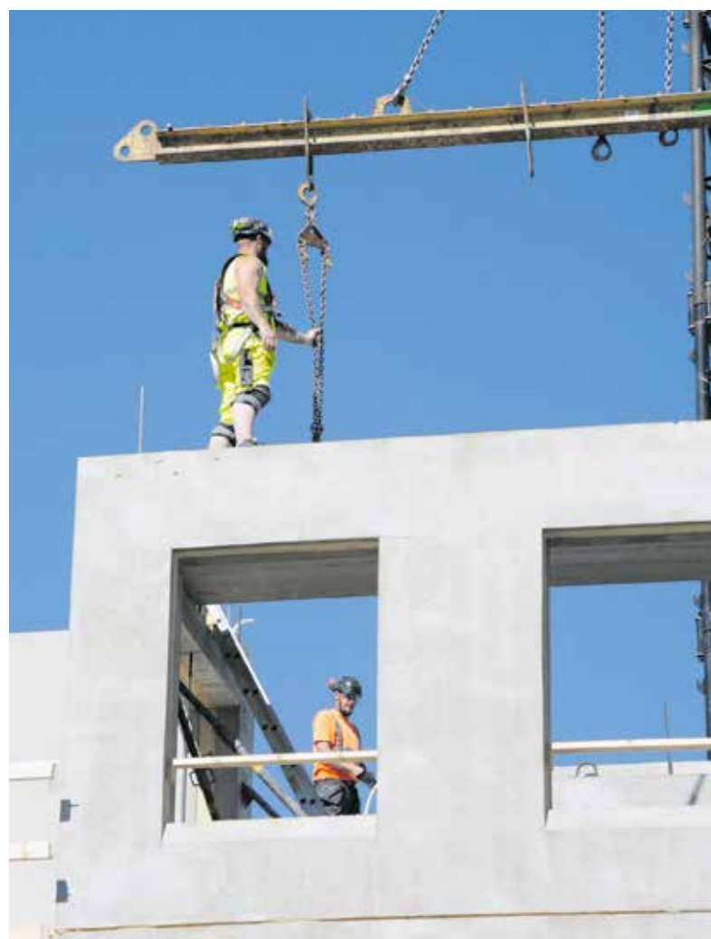
Tämä esimerkki Jatke Oy Uusimaan työmaalta Tikkurilasta. Tässä vanhemmat työntekijät näyttävät äärimmäisen huonoa esimerkkiä nuorille ja on tainnut omakin perehdytys jäädä väliin. Monen kymmen metrin korkeudessa heilutaan ilman turvaköyttä tai kaiteita.
