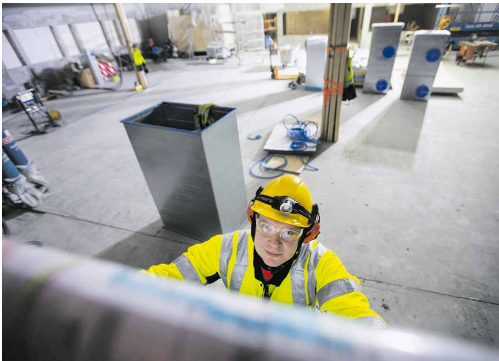
Putkimies Aku Leskinen Hatsalan koulun työmaalla Kuopiossa.
