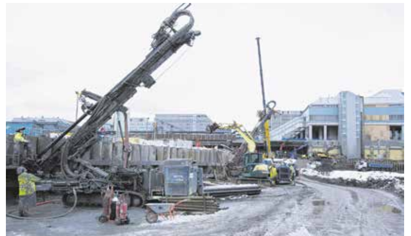
Triplan työmaata hallitsevat tällä hetkellä infra-ammattilaiset, jotka mahdollistavat tulevaisuudessa rakentajien pääsyn työmaalle.
