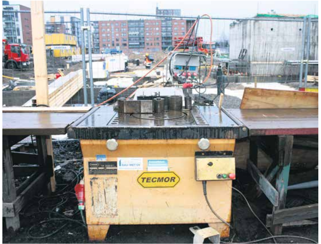
Skanskan työmaalla käytössä oleva taivutin koko komeudessaan.
