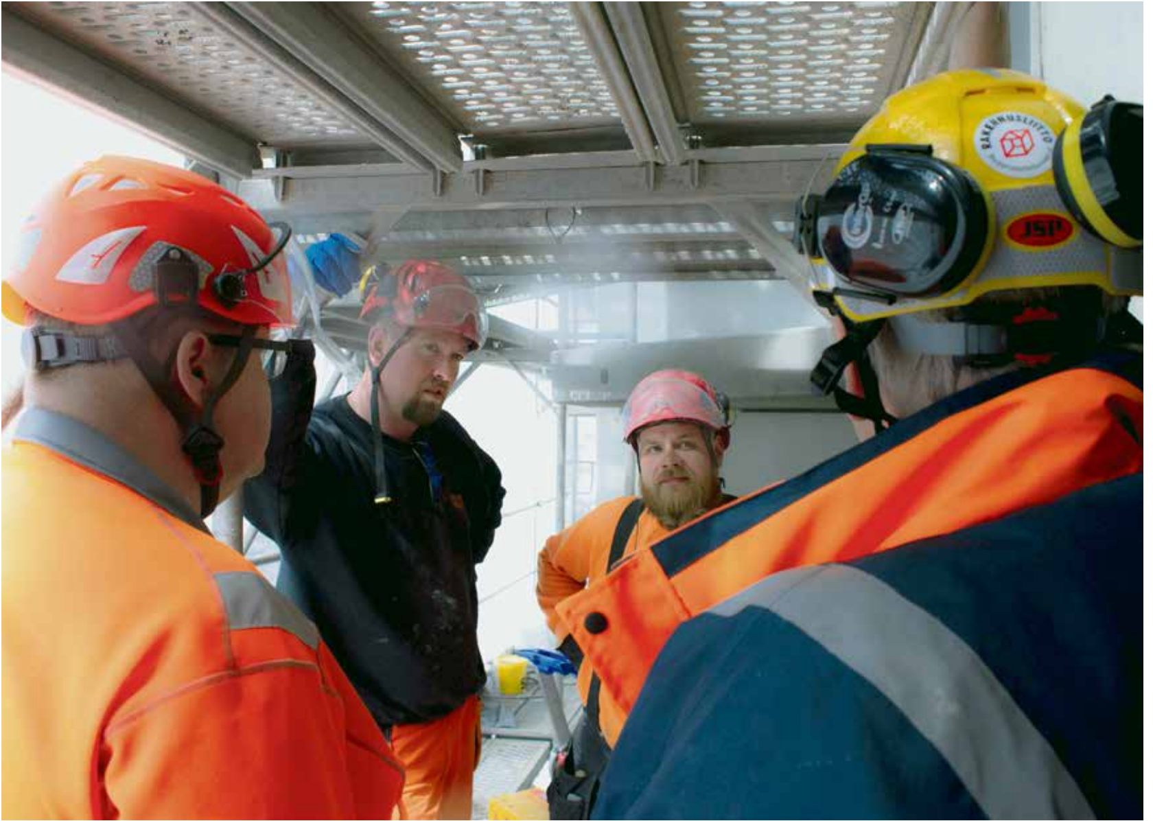
Rakennusliiton työmaakäynnit tulevat tarpeen, sanovat Mika Rissanen ja Jani Kinni.
