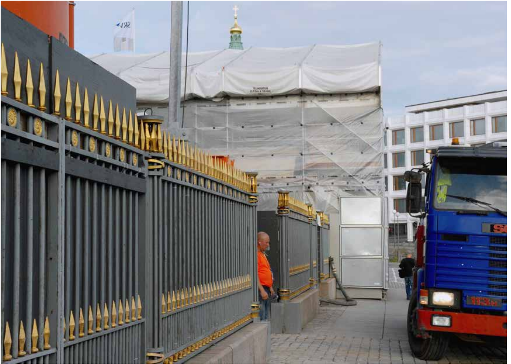
Presidentinlinnan peruskorjaustyömaalla edellytettiin turvallisuusselvitystä myös rakennusalan ammattilaisilta.
