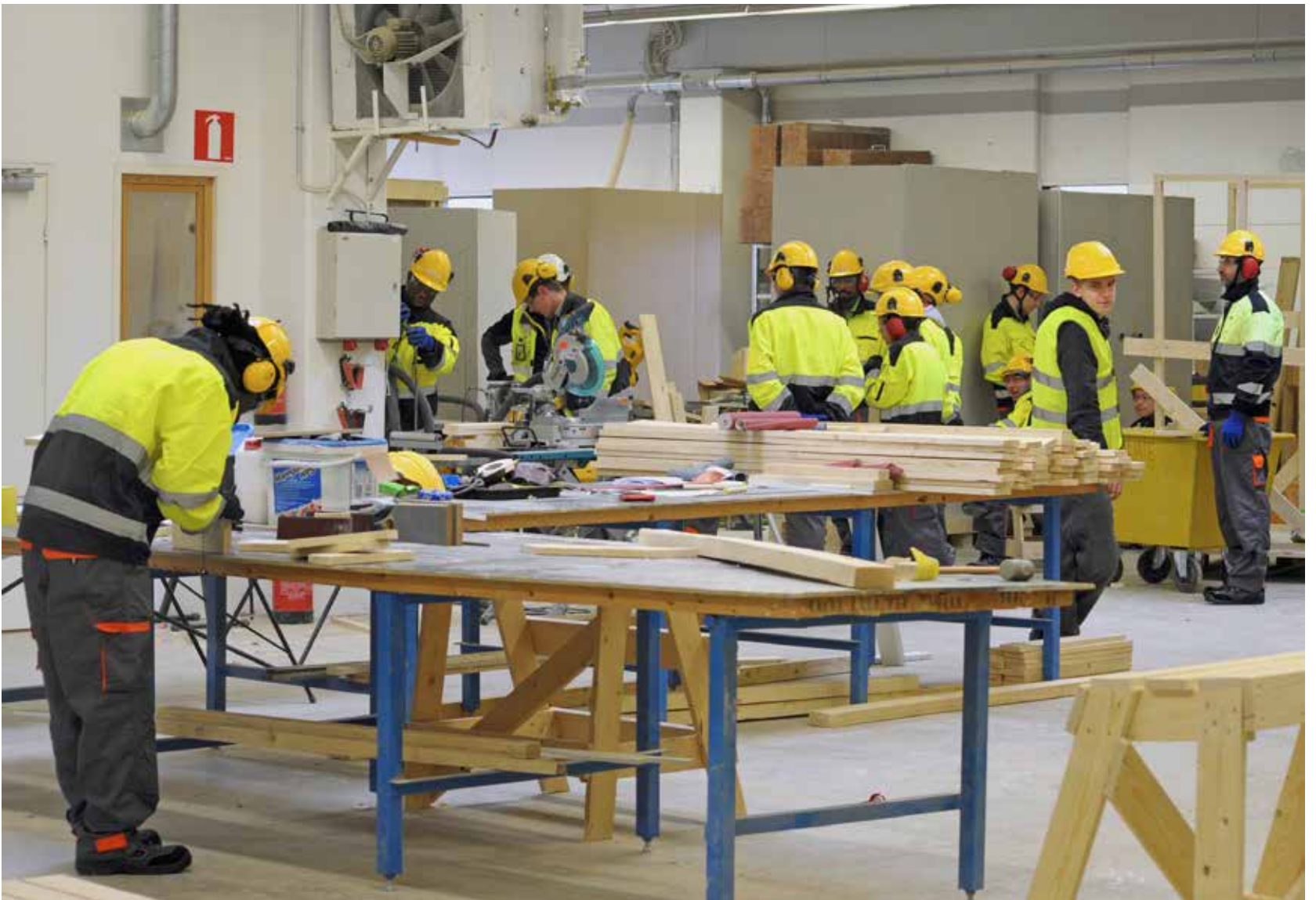
Ensin harjoitellaan hallissa, sitten oikealla työmaalla.
