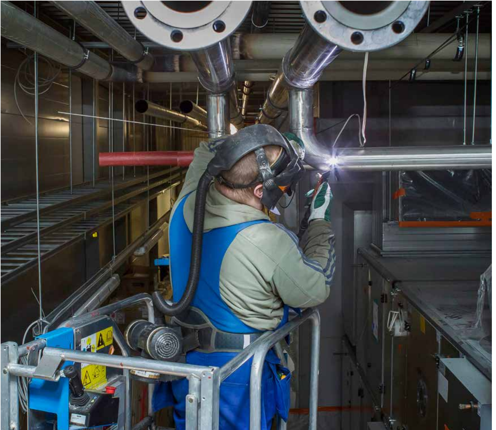
ARE:n Työsuojeluvaltuutettu Juha Kirjava hitsaa ruostumatonta terästä. Ilmaan leviää myrkyllistä kromia, jolle altistumisen huomaa metallisena makuna suussa. Hengityssuojaus on kunnossa.
