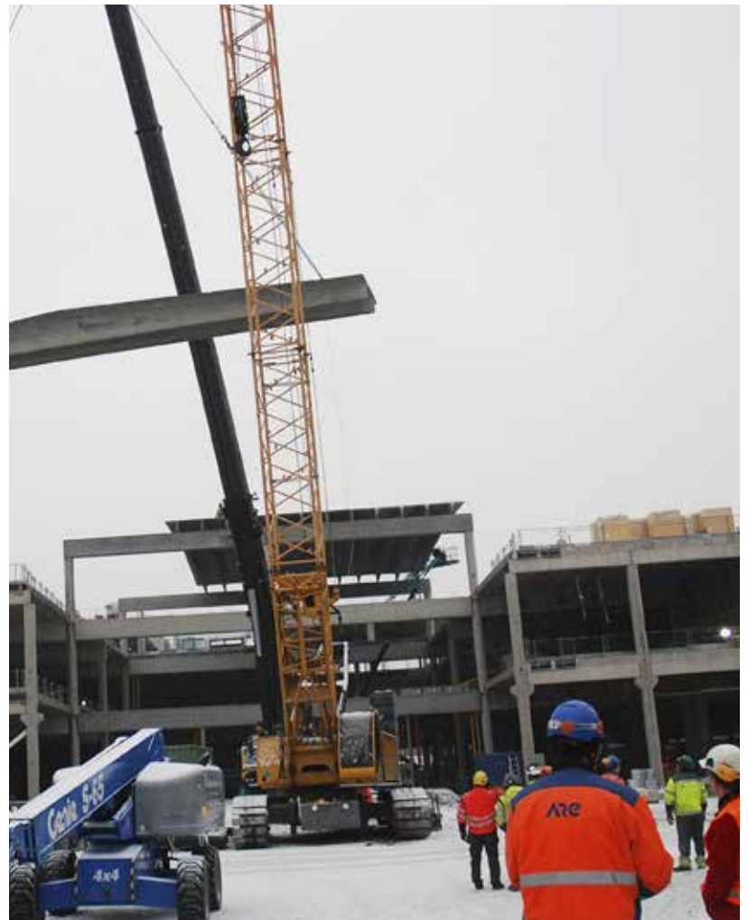
Kauppakeskus Myllyn työmaa.
