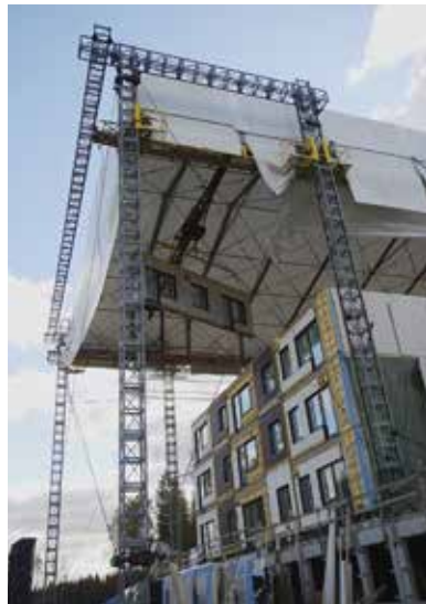
RKL Reponen on toiminut jonkinlaisena pioneerina teollisen puurakentamisen alueella. Kuvassa puukerrostalotyömaa Vantaan Kivistössä. Kuva: Johanna Hellsten
