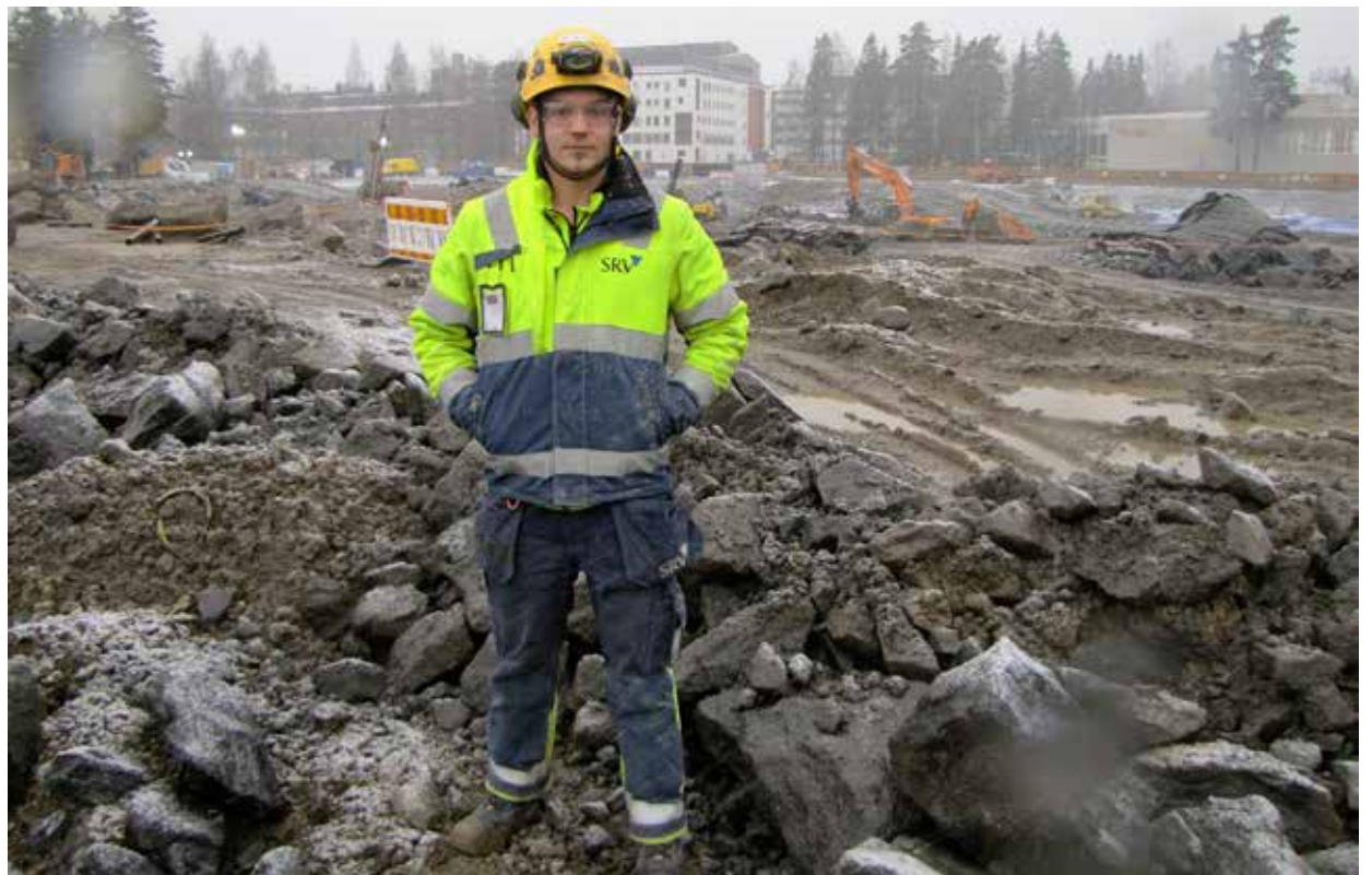
TAYS:n etupihatyömaan työsuojeluvuorutettua Jesse Heikkistä ei ikä paina: mies on vasta 25-vuotias.
