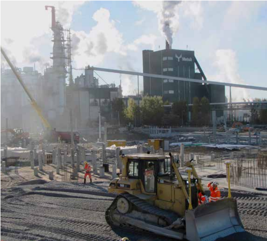
Vanha tehdas savuaa taustalla, kun uutta jo paalutetaan. Aikaisemmin ei ole rakennettu uutta sellutehdasta toimivan viereen.
