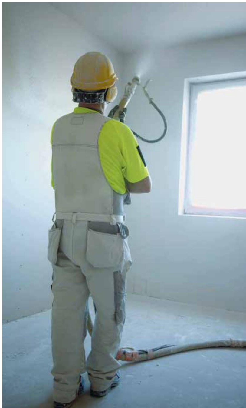
Valmisruiskutasoitetta on nopea levittää, vaikka melua siitä normaalilla tasoiteruiskulla levitettynä syntyy.
