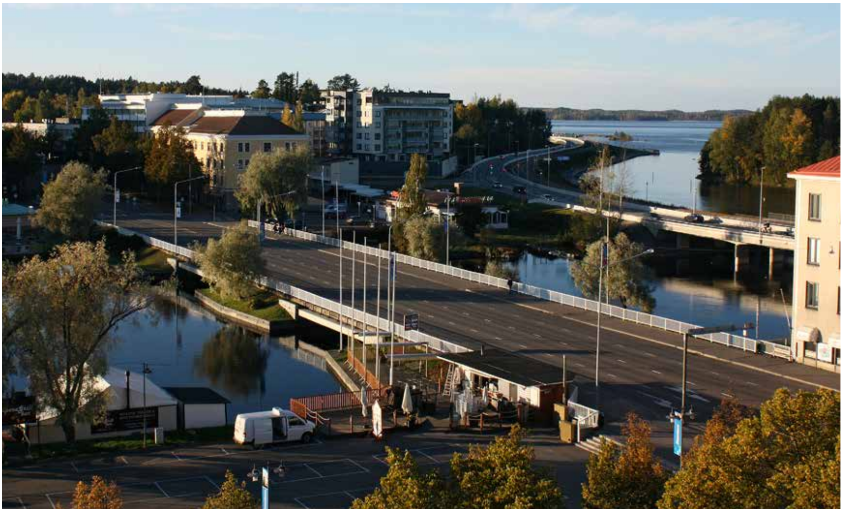
Savonlinnan alueelle tehdään syväväylän siirto, joka merkitsee parin uuden ison sillan rakentamista. Lisäksi uudiskohteita on ainakin Nojanmaalla ja Savolassa. Kuva Savonlinnan keskustasta.
