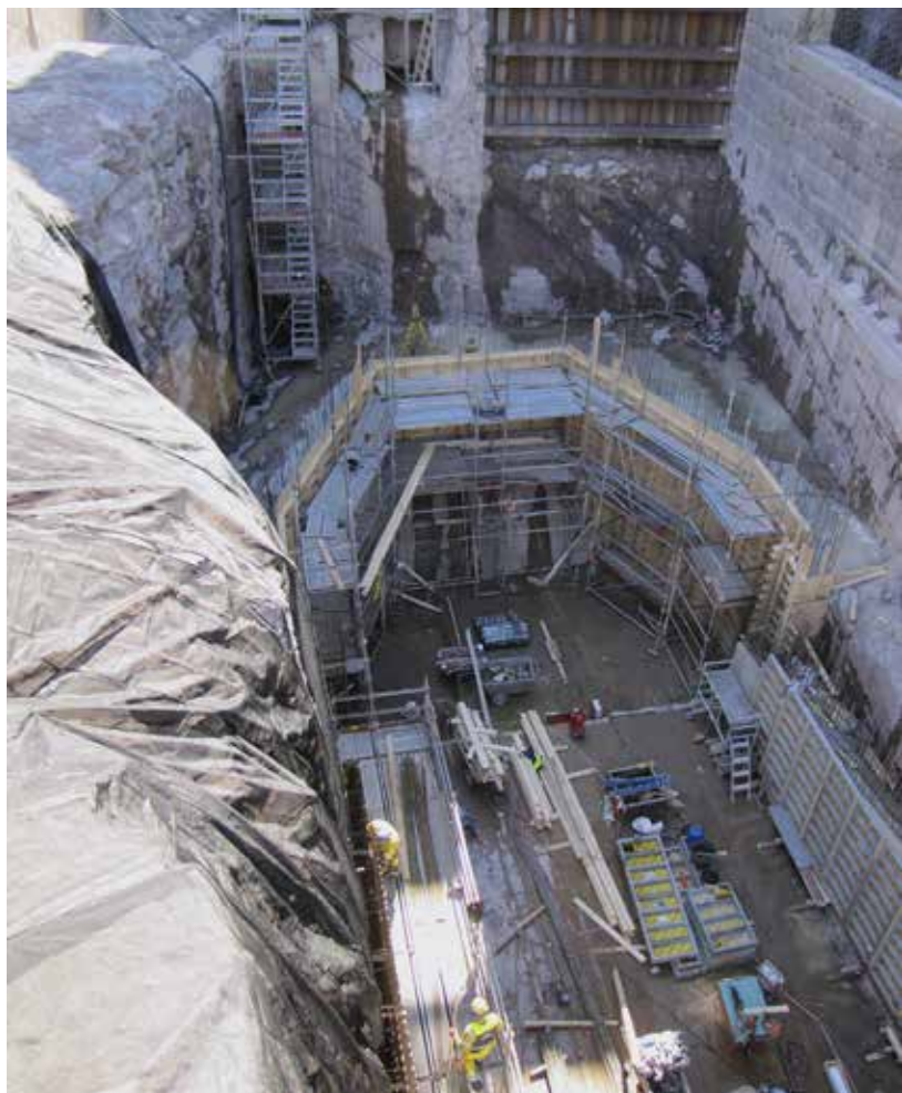
Harjavallan voimalaitoksen laajennustyömaalla on korkeuseroa yli 40 metriä, mikä asettaa työturvallisuudelle omat vaatimuksensa.
