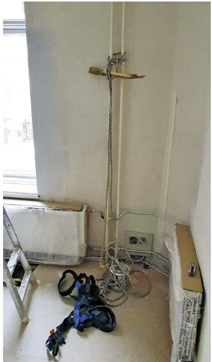
Ulkopokien maalaaja kehoitettiin kytkemään turvaköysi patteriputkiin.
