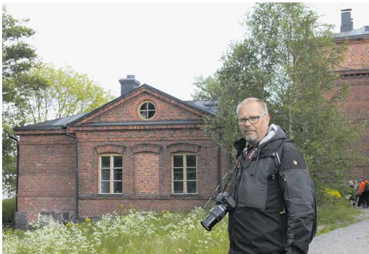
Vanha tiilinen saunarakennus on metsähallituksen kenttäpäällikkö Jere Rauhalan suosikkikohteita Vallisaarella. Se on kärsinyt kosteusvaurioista, mutta kunnostetaan yleisökäyttöön.
