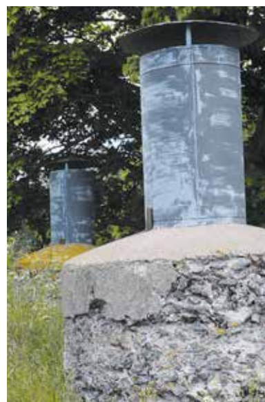
Säästöbetonin patinaa ilmastointiventtiilin kyljessä.
