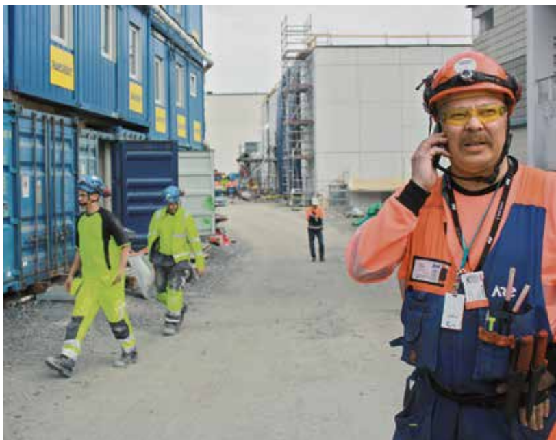
ARE:lla työskentelevä Marko Väisänen johtaa putkiporukkaa, johon kuuluu kymmenen asentajaa sekä apumies.
