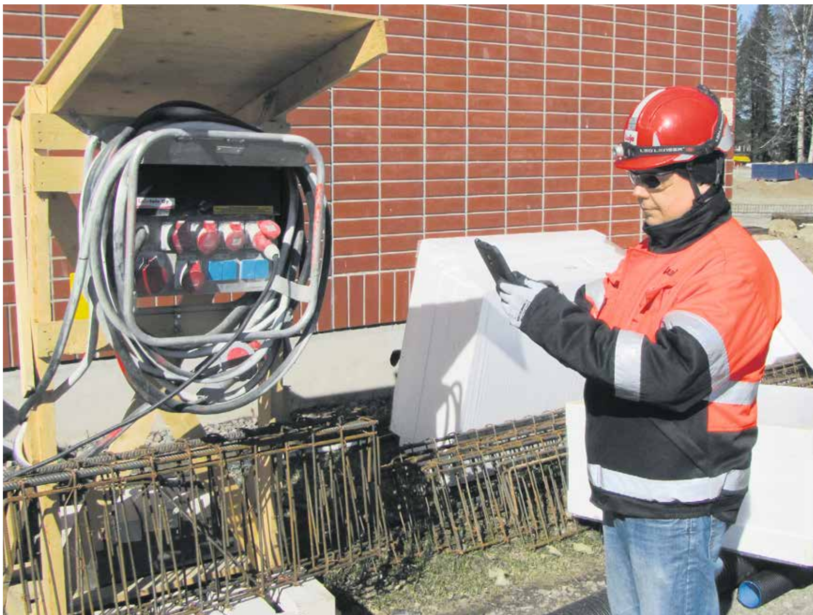
Sähkönjakelukeskus on oikein nostettu irti maasta, siitä Marko Metsäpelto merkitsee mobiililaitteeseensa plussan.
