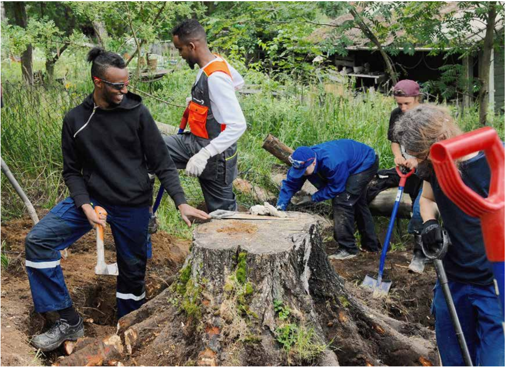
Said, 22 v, ja Ugaas, 21 v, osallistuvat järeiden kantojen ja juurten kaivamiseen huvilan rannalta, jonne he ryhtyvät seuraavaksi rakentamaan pukusuojaa. – Vartiosaassa on ollut kiva tutustua toisiin, muilta oppii paljon uutta, Said sanoo.
