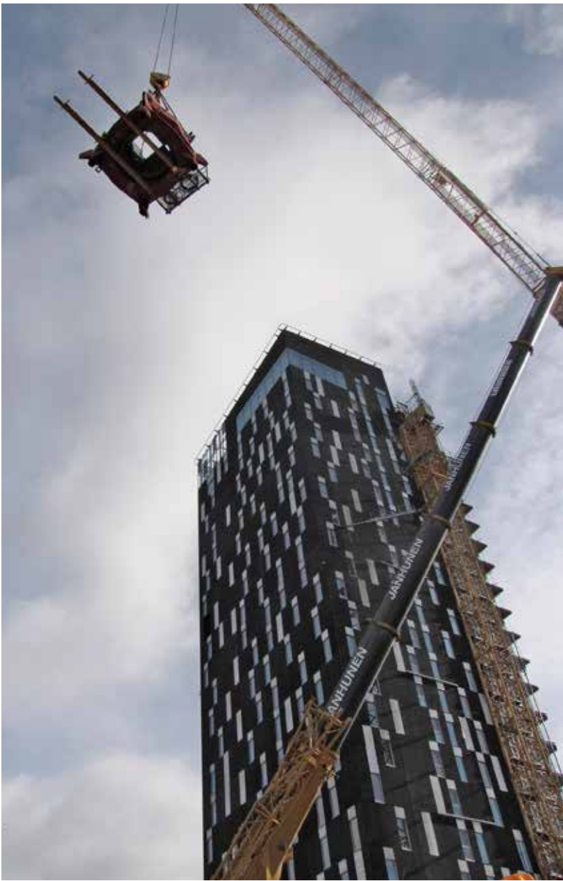
Taas lyhenee torninosturi muutamalla metrillä, kun kappale hilautuu alas.
