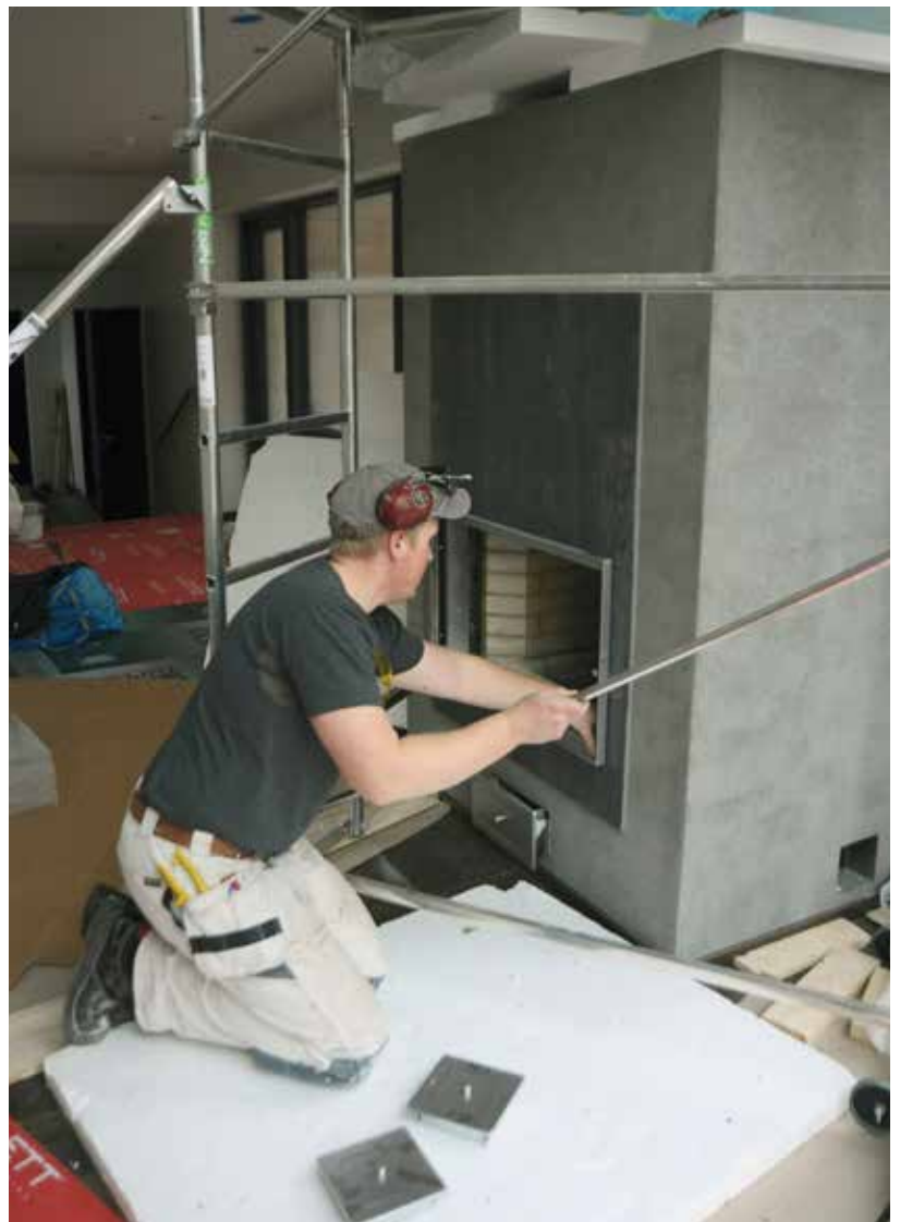
Jarmo Järvisen viimeisin takkatyömaa Kauniaisissa on jo sisustuskuunnossa. Viimeisenä hommana oli takan luukun asennus.
