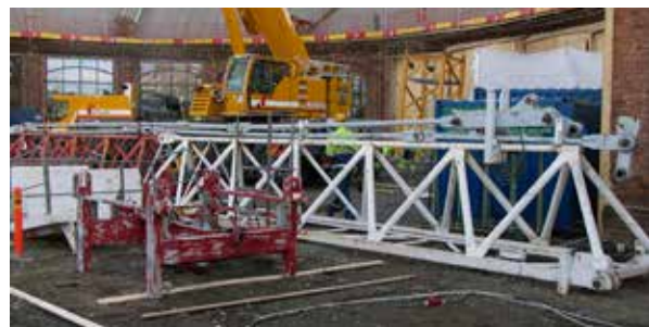
Nämä torninosturin runkokappaleet ovat jo laskeutuneet onnellisesti maankamaralle.
