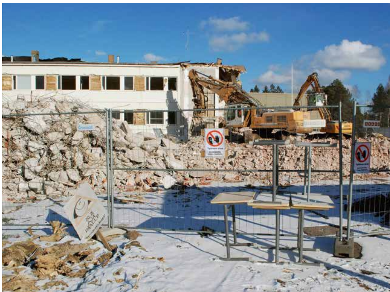
Ruukin yläkoulu murenee pala palalta maan tasalle. Remonttiin ei kannattanut ryhtyä, sillä se olisi maksanut lähes yhtä paljon kuin uuden rakentaminen.
