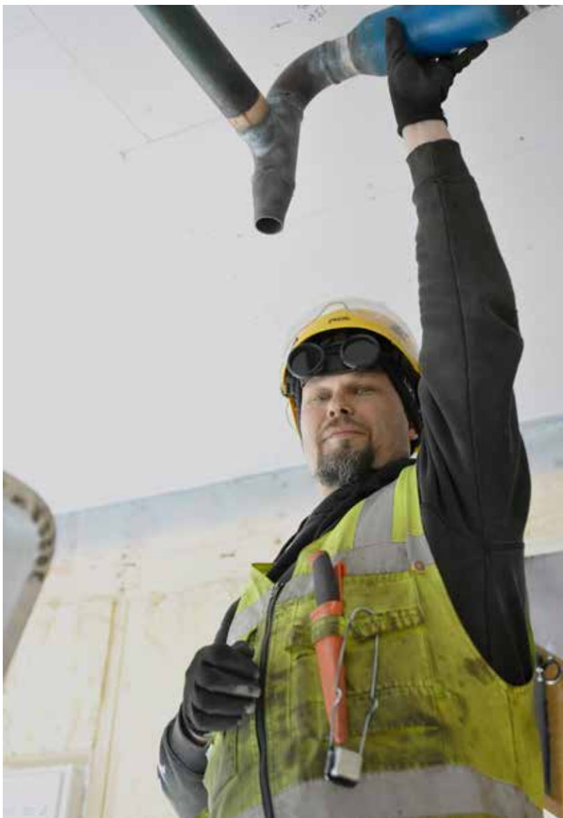
Pasi Kumpulainen on pitkää aikaa Pieksämäen Ysiysi-Rakennuksen työmaalla putkitöissä.
