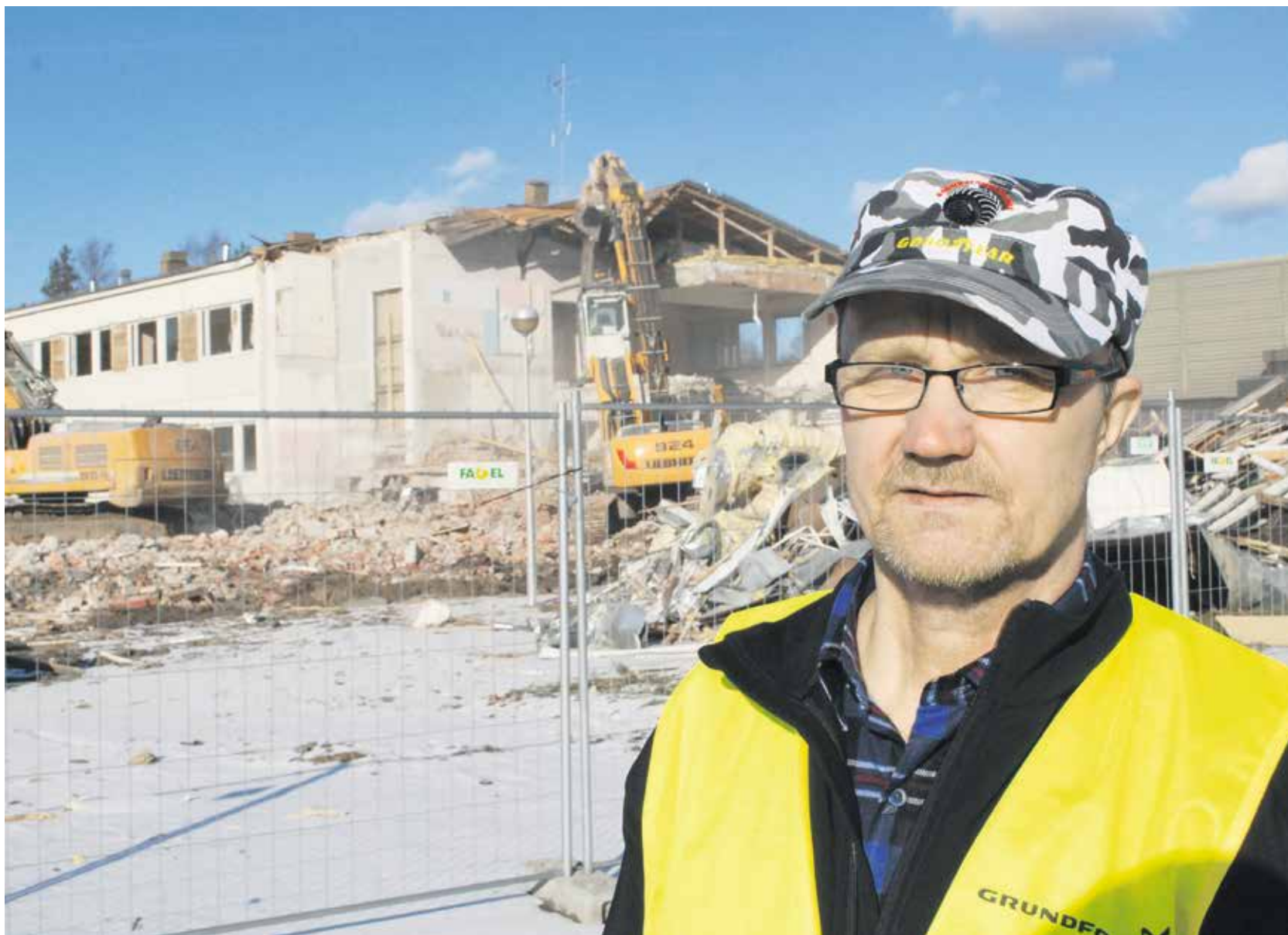
Kirvesmies Matti Pohjolle takana purettavana oleva Ruukin yläkoulu on tuttu paikka. Hän on aikanaan ollut tekemässä siihen remonttia ja laajennusta.
