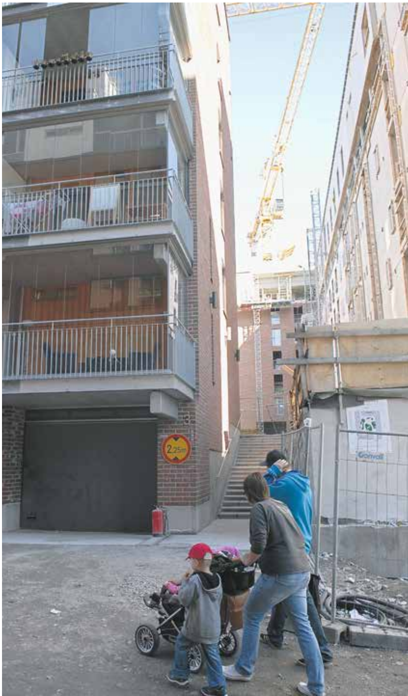
ATT:n ja NCC:n toisessa kerrostalokohteessa, joka kohoo kesällä valmistuneen Luotettava Laatutyömaa -pilottitalon viereen samassa korttelissa, ei käytetä kulunvalvontaa.
