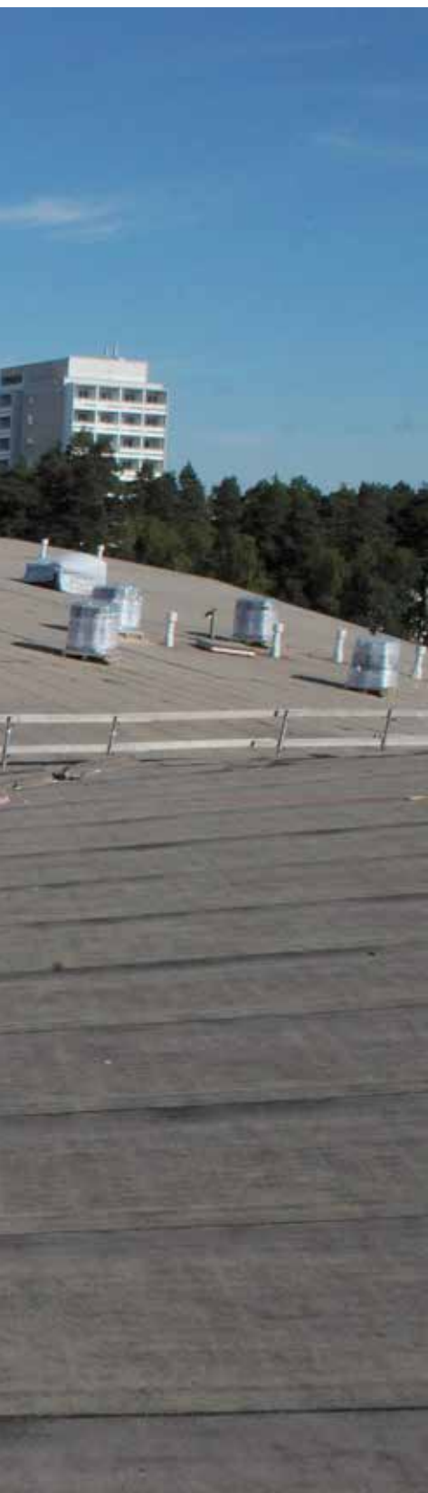
Kattomiehet saavat tohottaa kuumalla liekillä pitkään ennen kuin kaikki 45 000 neliötä huopaa on asennettu.
