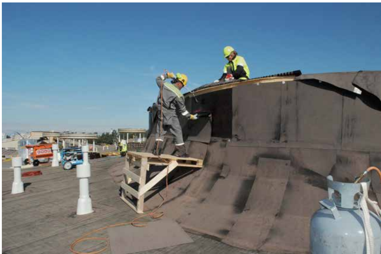
Kattomiehet saavat tohottaa kuumalla liekillä pitkään ennen kuin kaikki 45 000 neliötä huopaa on asennettu.
