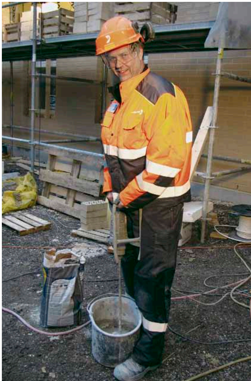
Muurarin työ käy käsien päälle, mutta viulustin taitoja se ei Raimo Nokelaiselta ole vionyt.
